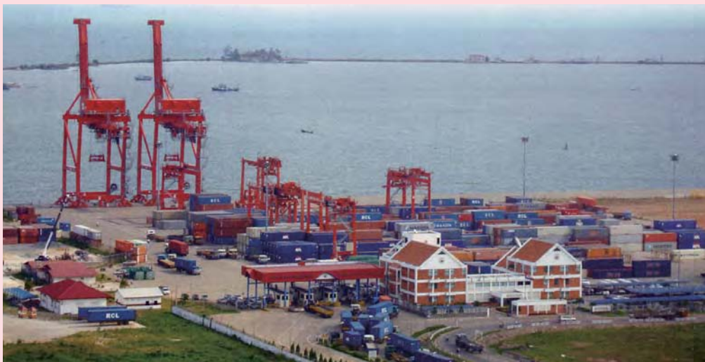
シハヌークビル港の全景。JICAは2基のコンテナクレーン(左)とコンテナ埠頭(右)の整備に協力。
