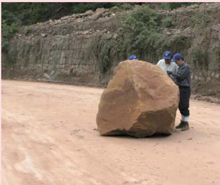
落石調査(落石の大きさ、落下形態、破損状況などをチェック)。
