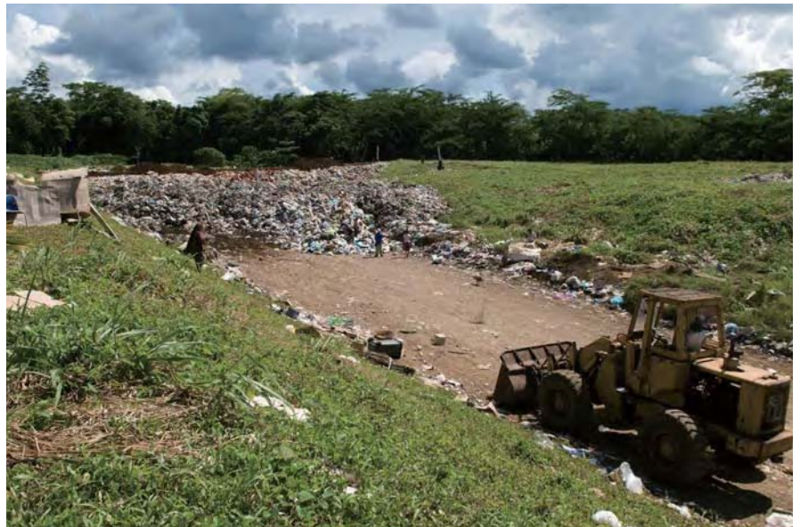
「福岡方式」を取り入れ、改善されたサモアのタファイガタ処分場。ゴミ収集車が到着すると、まずウエイストピッカーがゴミのなかから有価物を探す。その後、重機でゴミを一カ所に集め、踏み固める。
