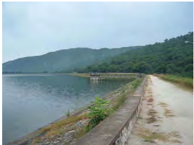
Mona 浄水場 貯水池と取水塔
