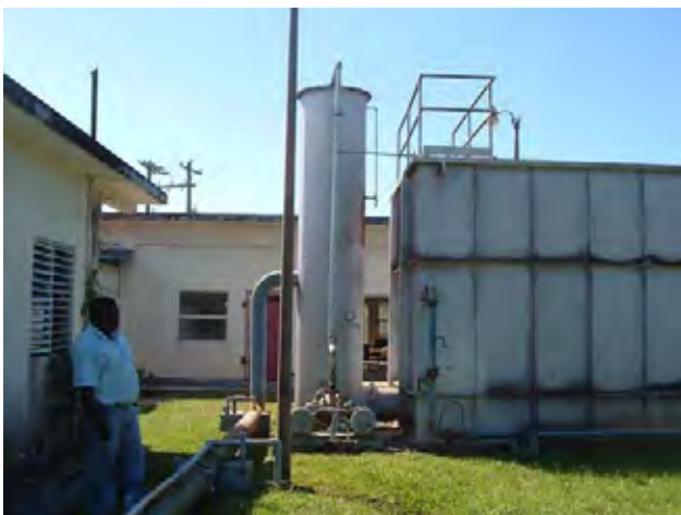
Bull Strode 浄水場 鋼製凝集沈殿池: 構造物は比較的良好に維持管理されている。
