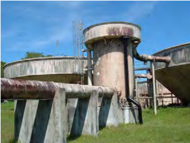
Bogue 浄水場 取水管、着水井と沈殿池： 維持管理は比較的良好に行われている。
