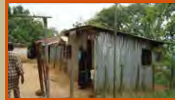
Mfum 関税局現場事務所外観。 左の建物は入管局事務所。
