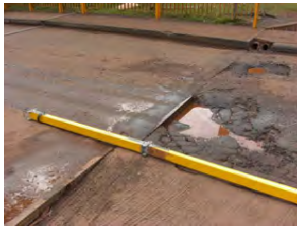
写真3-10 ルワンダ側の取り付け道路は橋梁端部と段差なし
