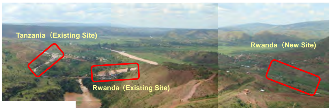
写真4-1 ルスモ OSBP 事業サイトの全景
