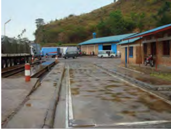
写真3-23 ルワンダ BP/旧ウェイブリッジ (左)、新ウェイブリッジ(右)
