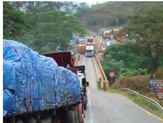
写真3-22 タンザニア側からルワンダ BP を望む
