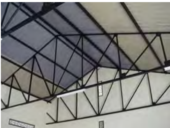
写真2-14 倉庫の内部(屋根)
