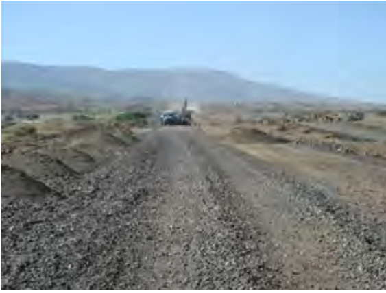
写真2-2 道路改良工事 (タンザニア側/JBIC 融資区間)
