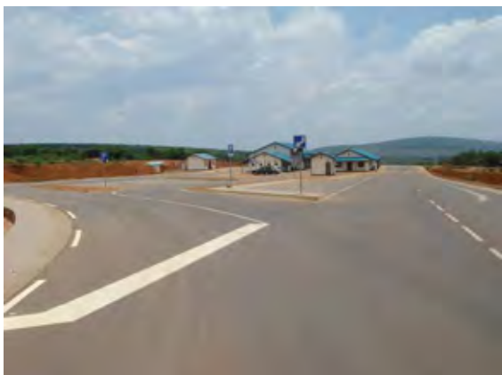
写真2-10 ネンバ OSBP の全景 (ルワンダ側より望む)
