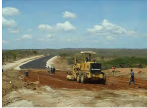
写真2-9 道路改良工事 (ケニア側/AfDB 融資区間)
