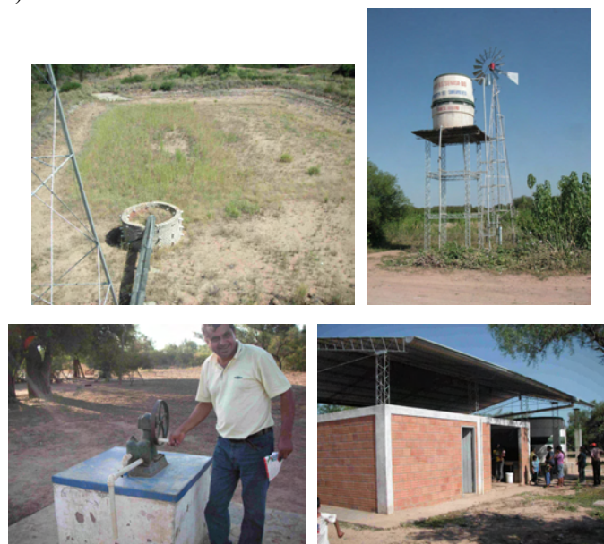
Foto arriba izquierda: Tajamar (estanque), Foto arriba derecha: Molino y Tanque elevado, Foto abajo izquierda: Depósito subterráneo, Foto abajo derecha: Establecimiento sanitario (recolección de agua pluvial)
