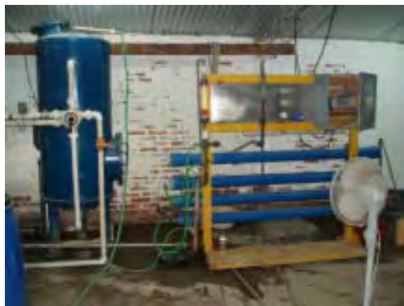
Ciudad de Filadelfia, departamento de Boquerón zor central del Chaco en la región occidente La única aguatera privada dentro de la ciudad. La fuente de agua es un pozo y como tiene una alta salinidad, utiliza desalinizador de resina de intercambio iónico. Realiza la distribución a una parte de la zona y vende en botellas.
