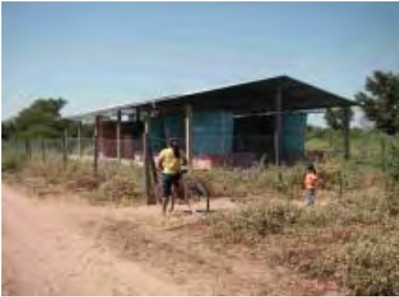
Sistema sanitario de Timoteu del departamento de Boquerón (región occidental)
