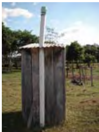
Letrina ventilada, departamento de Guaira Letrina ventilada construida por la SENASA dentro del recinto de una vivienda. Se ha construido esta letrina en todas las viviendas de la comunidad. Sólo los materiales fueron objeto de donación, por lo que los propios habitantes han construido la letrina.
