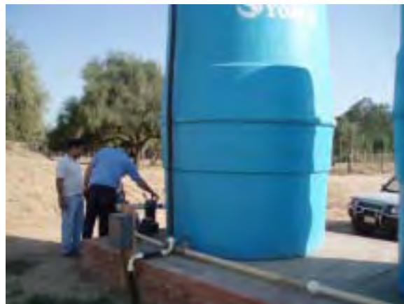
Ciudad de Filadelfia, departamento de Boquerón zor central del Chaco en la región occidente Tanque ubicado al lado de la laguna. Se bombea a la comunidad indígena aledaña. Los pobladores trabajan muchas veces dentro de las plantas de la cooperativa menonita, y compran el agua.
