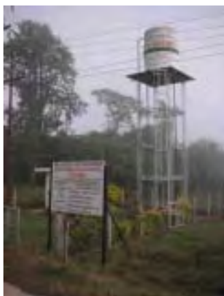
Tanque de distribución de Teniente Bogado, departamento de Guaira
