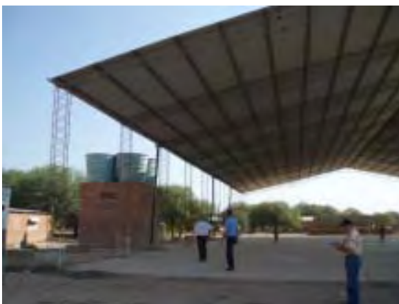
Ciudad de Filadelfia, departamento de Boquerón zor central del Chaco en la región occidenta Los aljibes construidos por la cooperación financiera no reembolsable para los proyectos comunitarios. Parte de los tanques de almacenamiento no tienen tapas, y su cañería de conexión están rotas. En los alrededores de la Ciudad de Filadelfia, la cooperativa menonita insta al responsable de la comunidad indígena a realizar los mantenimientos.
