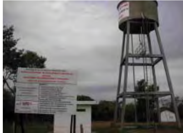
Tanque de distribución y oficina de control de pozo de San Librada, departamento de Misiones
