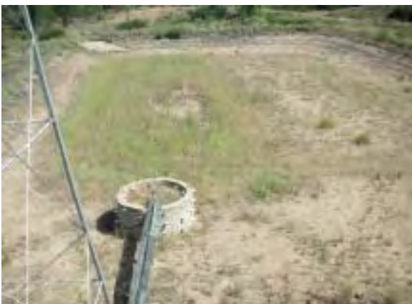
Pozo de acumulación del tajamar de Tomoteu, en Boquerón (región occidental)
