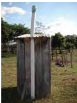
Letrina ventilada, departamento de Guaira Letrina ventilada construida por la SENASA dentro del recinto de una vivienda. Se ha construido esta letrina en todas las viviendas de la comunidad. Sólo los materiales fueron objeto de donación, por lo que los propios habitantes han construido la letrina.
