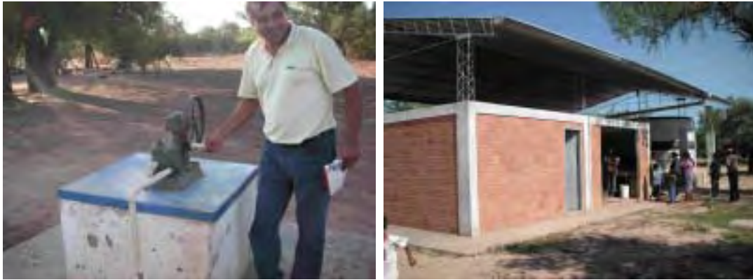
Foto arriba izquierda: Tajamar (estanque), Foto arriba derecha: Molino y Tanque elevado, Foto abajo izquierda: Depósito subterráneo, Foto abajo derecha: Establecimiento sanitario (recolección de agua pluvial)
