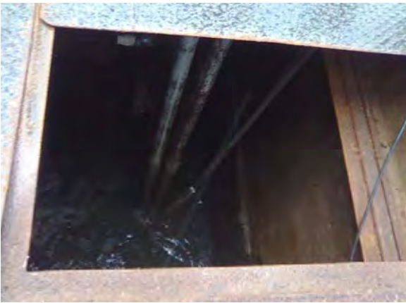
Este市 沈砂池(地下)
