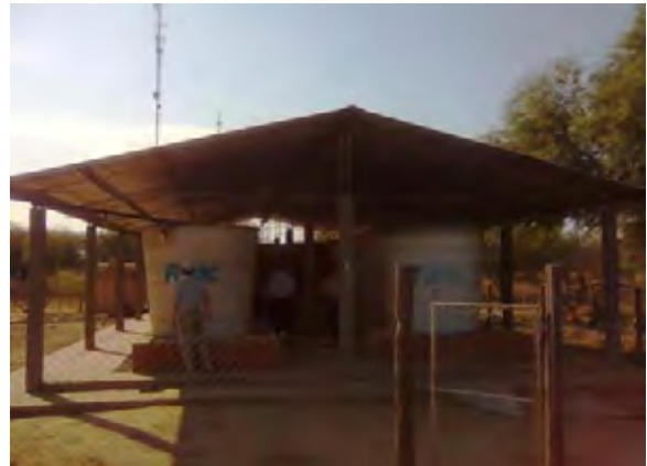
Filadelfia市 雨水集水施設
