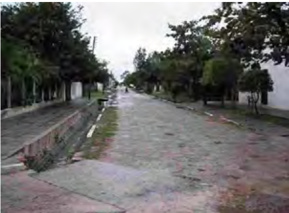
Pilar市 側溝(開渠)
