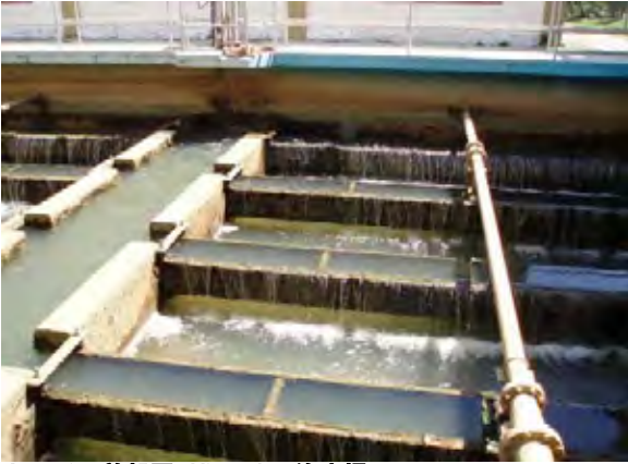
Asunción首都圏 Viñas kue浄水場 薬品沈殿池
