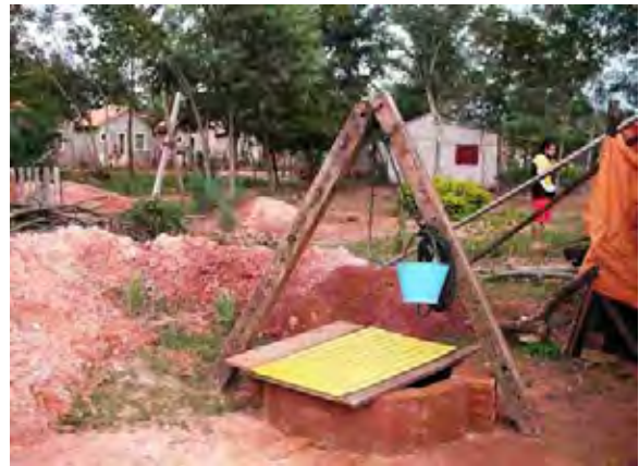
Caaguazu県 Mercedes村 MERCOSURの支援による「アセンタメント」支援プロジェクト 浅井戸 施設が機能せず、住民側による掘削
