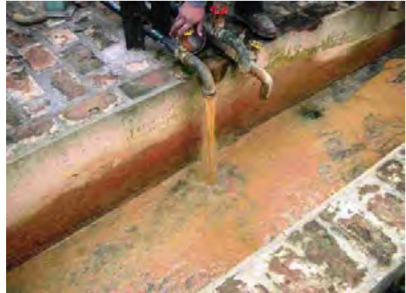
Neembucu県 Isla Umbu市 圧力式プラントからの排水
