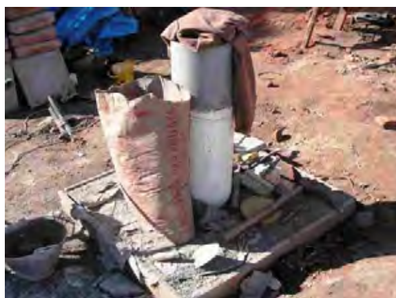
Guaira県 円借款「農業部門強化事業II」により建設中の井戸
