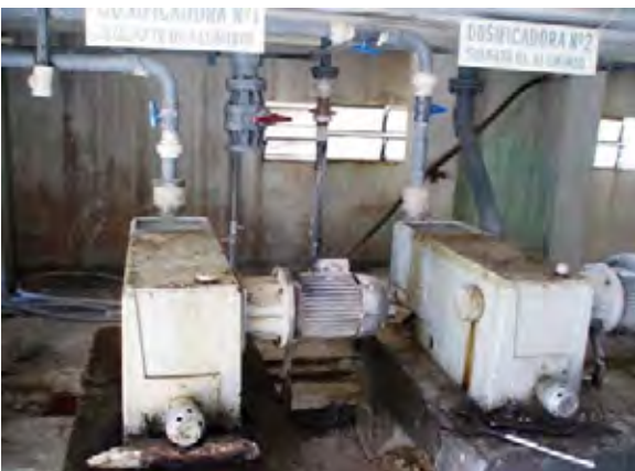
Asunción首都圏 Viñas kue浄水場 薬品注入器(硫酸アルミニウム)
