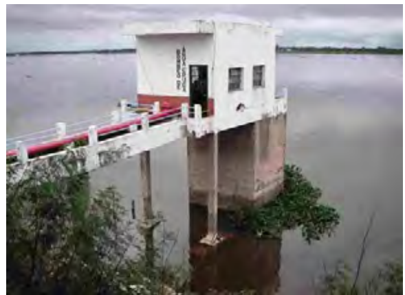
Pilar市 取水塔
