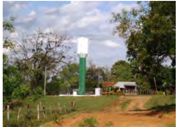
Conl.Obeide市 住民組合 高架タンク 県援助による住民組合の給水施設
