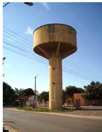
San Estanislao市 高架タンク
