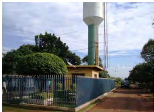
Conl.Obeide市 高架タンク 県援助による住民組合の給水施設
