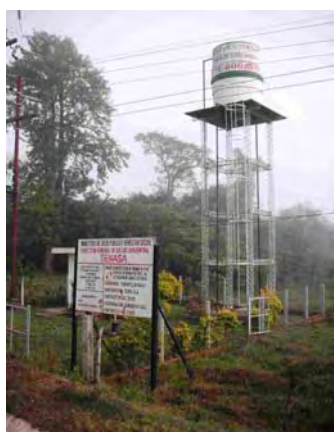
Guaira県 Teniente Bogado村 世銀(BIRF4)の支援によって建設された高架式配水池
