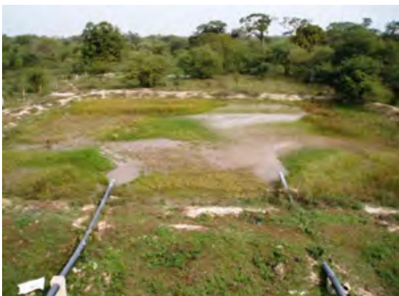
Falcon市 浄水場施設からの排水
