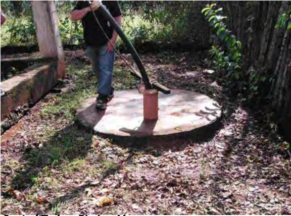
Central県 Las Piedras村 世銀の支援によって建設された高架式配水池 配水池下部に遮水シールドが施されていない井戸が増設されている
