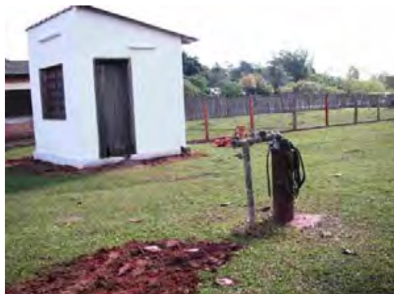
Guaira県 Itape市 世銀(BIRF2)の支援によって建設された井戸
