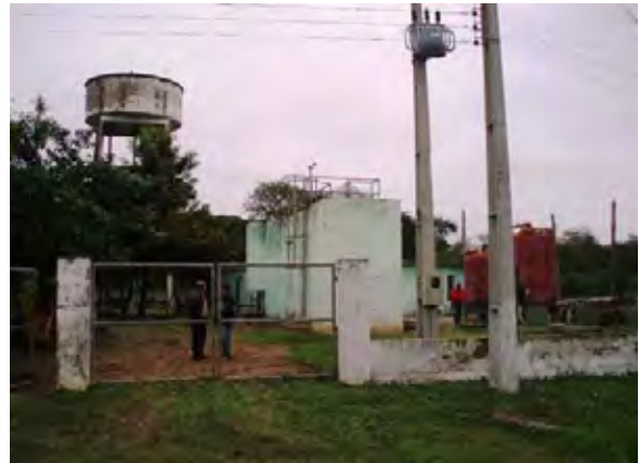
San Pedro市 水衛生委員会による浄水場 浄水場施設 (ドイツ援助による)
