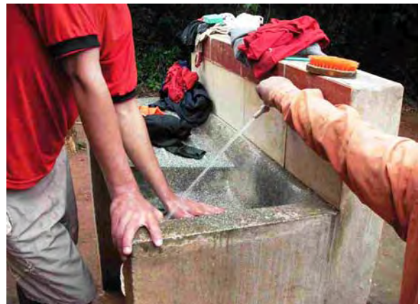
Caazapa県 San Jose Centro村 IDB事業対象村落 同事業で建設された洗濯場
