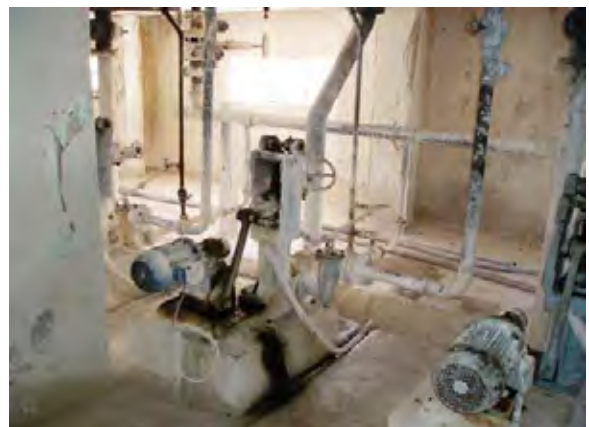
Asunción首都圏 Viñas kue浄水場 薬品注入器(石灰)
