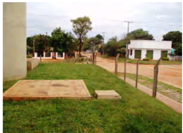
Caaguaz市 配水池バルブボックス
