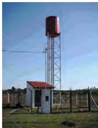
Guaira県 Nande Rogara村 CONAVI-台湾政府が建設している「アセンタミエント」対策のための高架式配水池と制御建屋
