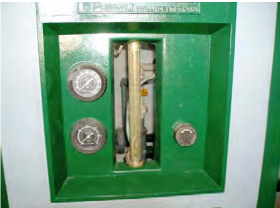
Asunción首都圏 Viñas kue浄水場 塩素注入器
