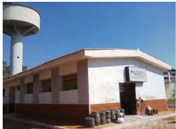
Concepcion市 浄水場施設
