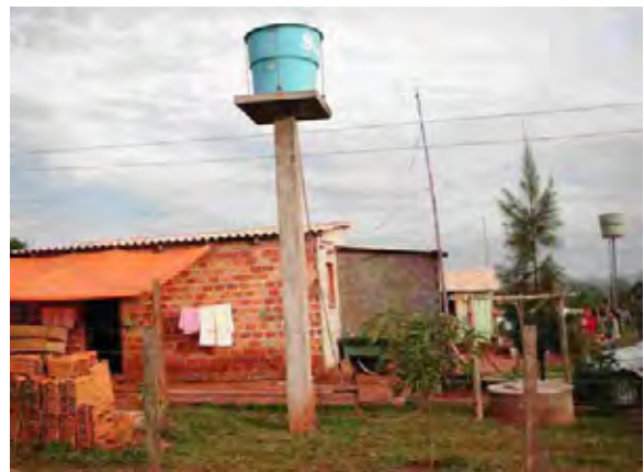
Canyndeyu県 Nuevo Horizonte村 未給水村落 「アセンタミエント」村落にある浅井戸と高架水槽
