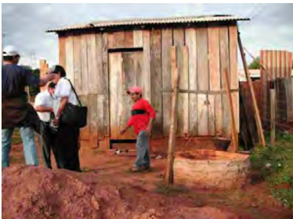
Canyndeyu県 Nuevo Horizonte村 未給水村落 「アセンタミエント」村落にある浅井戸
