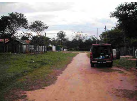
Caaguazu県 Quinta Neluye村 未給水村落 隣接する村落の高架水槽が写真中央に見える
