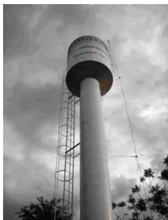
Caaguazu県 Calle Guazú村 高架水槽 (IDB)
