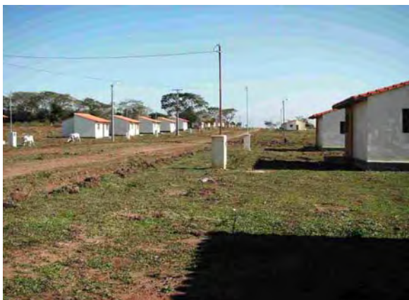
Guaira県 Nande Rogara村 CONAVI-台湾政府が建設している「アセンタミエント」対策のための村と住居
