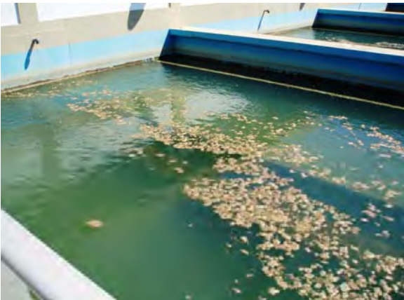
Asunción首都圏 Viñas kue浄水場 急速ろ過池
