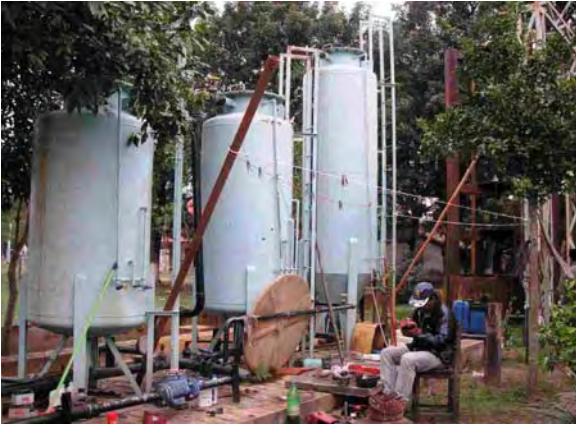
Neembucu県 Isla Umbu市 世銀(BIRF4)の支援によって建設された鉄分除去のための圧力式プラント
