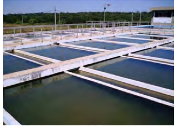
Asunción首都圏 Viñas kue浄水場 急速ろ過池
