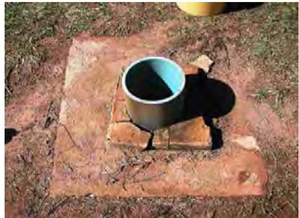
Paraguari県 IDBによって掘削された井戸 揚水量が不十分のため破棄されたため、土地所有者が個人的に使用している
