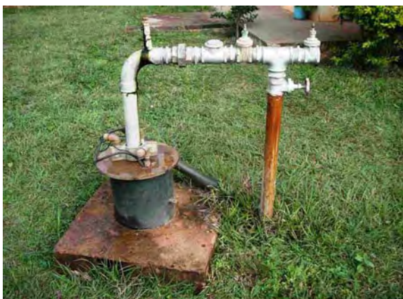
Guaira県 Teniente Bogado村 世銀(BIRF4)の支援によって建設された井戸
