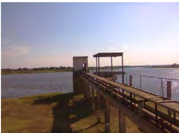
Concepcion市 取水塔
