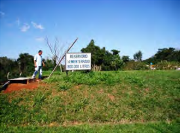
San Estanislao市 配水池
