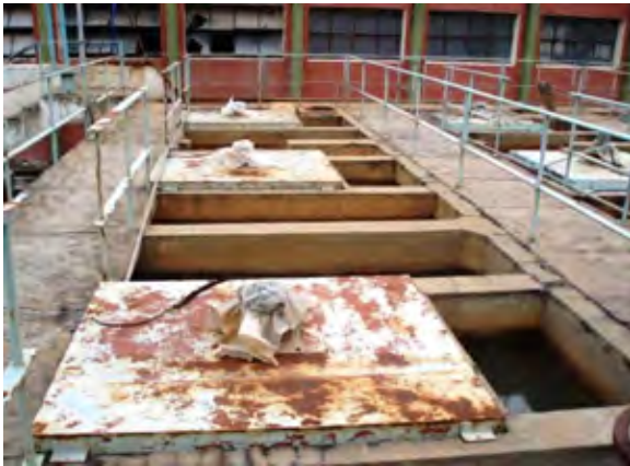
Villarrica市 混和池
