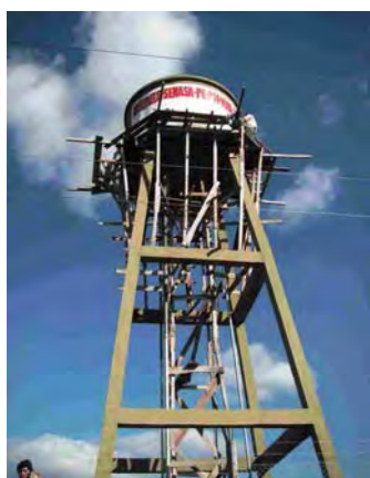
Guaira県 円借款「農業部門強化事業II」により建設中の高架式配水池
