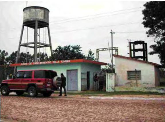
Neembucu県 Isla Umbu市 世銀(BIRF4)の支援によって建設された高架式配水池と作業建屋兼水衛生委員会事務所
