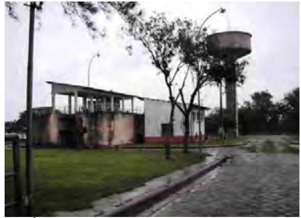
Pilar市 浄水場施設
