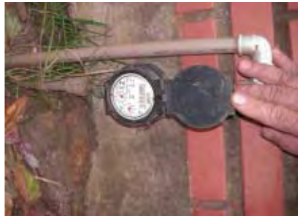
イタプア県 Anteguera 水道メーター 無償案件「東部地域給水整備計画」対象村落 民家の庭先にある水道メーター。本村落では100%の設置率である。一月の使用水量は基本料(15m3)を超えることはあまりないとのことであった。
