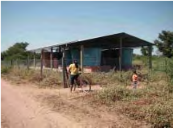
ホケロン県(西部) Timoteu 衛生施設(Systema de Sanitario) 衛生施設はタマルからの揚水を貯蓄するとともに、屋根に降った降水を貯水槽に貯蓄するシステム。飲用として利用される他、洗濯用水栓、シャワー施設が備わっている。しかし、タマルに水がなく、降雨も少ないため、施設は使われておらず、破損箇所が多いなど管理体制が十分でなかった。
