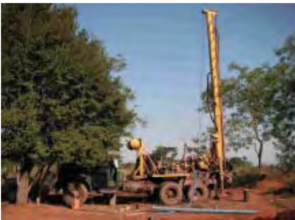
コセブション県 Carlos Antonio Lopez Km15 民間業者井戸掘削機 円借款「農業部門強化事業II」対象村落 SENASAが外注した民間業者のロータリー式井戸掘削機。掘削前のセッティング段階であった。
