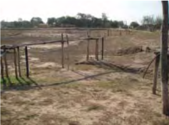
西部Central Chaco ホケロン県 Filadelfia市 メノータ組合で運転されるTajamar(タハマル)。今年は渇水のため水が溜まっていないが、例年ならば* * mほど湛水しているとのこと。砂層には水があり、池内に入れた井戸から揚水している。
