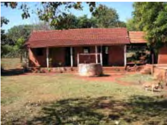
イタプア県 Champichuelo 手掘井戸 無償案件「東部地域給水整備計画」対象村落 民家前の手掘井戸(約3m深)にある。硝酸等汚染の指標は検出されなかった。手掘井戸のほか無償案件による給水システムも所有している。
