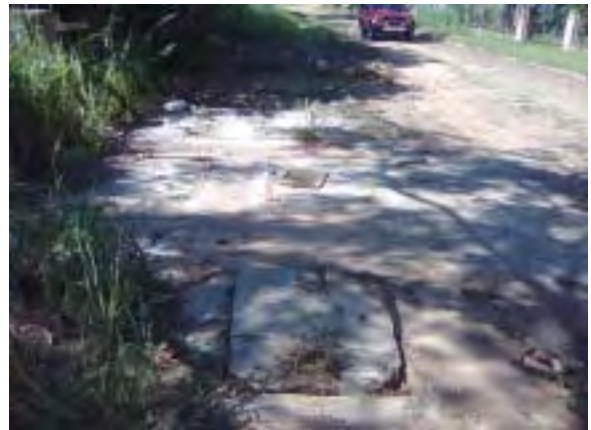
セントラル県 San Bernardino市 下水道、市内の送水ポンプ。
