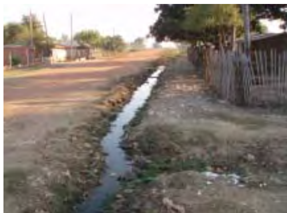
東部 Concepción県 Concepción市 下水管がない場合、汚水は道路側へ垂れ流しになる。この地域は、平坦地であるため、汚水は流れず、溜まったままとなる。
