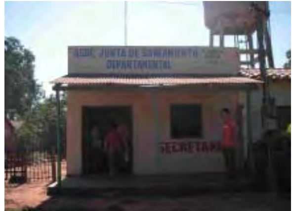
コセブション県 "水・衛生委員会連盟"事務所 (Holqueta) Holquetaの水衛生委員会の敷地内にコセブション県の連盟事務所がある。32の水・衛生委員会が集まり組織され、各委員会の組織強化・支援を実施している。
