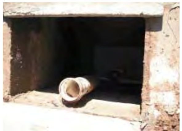
グアイラ県 Nande Rogara 浄化槽の構造 浄化槽の内部。槽内上流から生活排水が流入し、下流に位置する浸透ますへうわ水のみ越流する構造である。写真は流入管であるが、槽の反対側に流出管が設置され、浸透ますに続いている。
