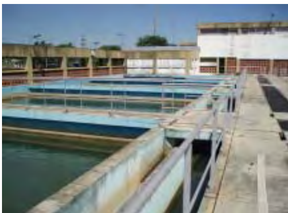
アスンシオン首都圏 Viñas Cué浄水場 急速ろ過池。フロックのキャリーオーバーが見られた。
