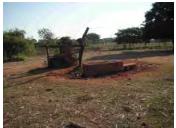
コセブション県 Carlos Antonio Lopez Km15 手掘井戸 円借款「農業部門強化事業II」対象村落 民家から5m程度はなれた所に掘られた手掘りの浅井戸。家畜の水飲み場が隣接している。井戸水から亜硝酸が検出され、家畜の糞、生活排水や汚水の混入の可能性がある。また付近に除草剤を散布していることから、地下水の汚染も考えられる。
