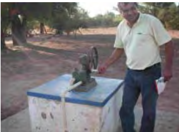
ホケロン県(西部) Timoteu 地下式貯水槽からの取水用として設置された回転式ハンドポンプ。
