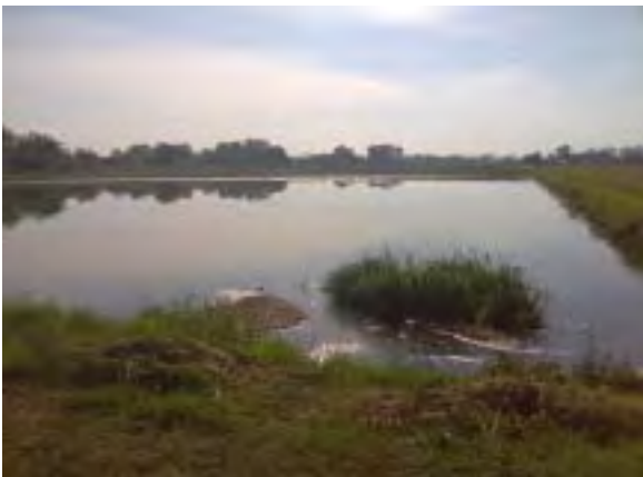
セントラル県 San Lorenzo市 ESSAPによる下水処理場。ラグーンタイプ、通性池 - 1。
