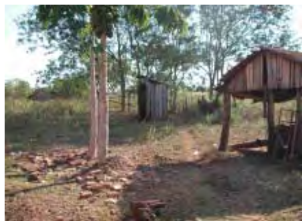
コセブション県 Carlos Antonio Lopez Km15 屋外式トイレ 家屋から10m程度はなれたところに設置された屋外型簡易トイレ。換気扇式でなくSENASAの基準によると衛生的ではないトイレに分類される。
