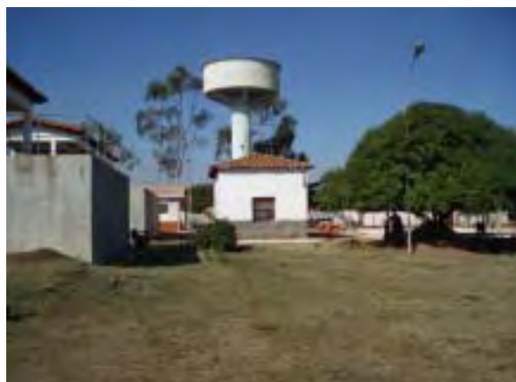
東部 Concepción県 Concepción市 ESSAP浄水場。
