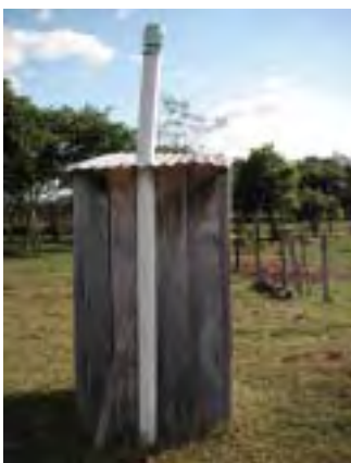
グアイラ県 換気扇付き簡易トイレ 民家敷地内に設置されたSENASAが建設した換気扇付き簡易トイレ。村落の全ての家庭に対して建設されている。資材のみ供与され、建設自体は住民が実施した。
