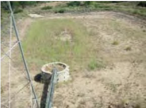
ホケロン県(西部) Timoteu タマル内部の集水井戸 タマルは地表を掘下げることで人工池を作り、雨水を貯蓄する。設置されたレキを充填した集水井の中心部より揚水することで、ろ過させるシステム。集水井が詰まりやすいとの理由で直接水面から取水するように改良されていた。また底部に漏水防止策が施されていないため、雨水はすぐに地下に浸透してしまう。
