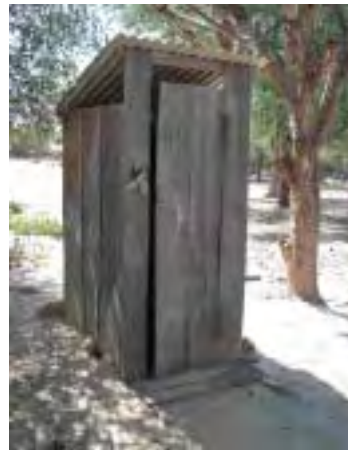
ホケロン県(西部) Santa Helena 屋外式トイレ 屋外型の簡易トイレ。下部は1m程堀抜きされており、汚物で一杯になった場合には埋め戻し、場所を変えて再度設置される。SENASAでは、汚物貯蓄槽にベンチレーション用配管を付け、発生するガスを外部に排出するシステムを採用している。
