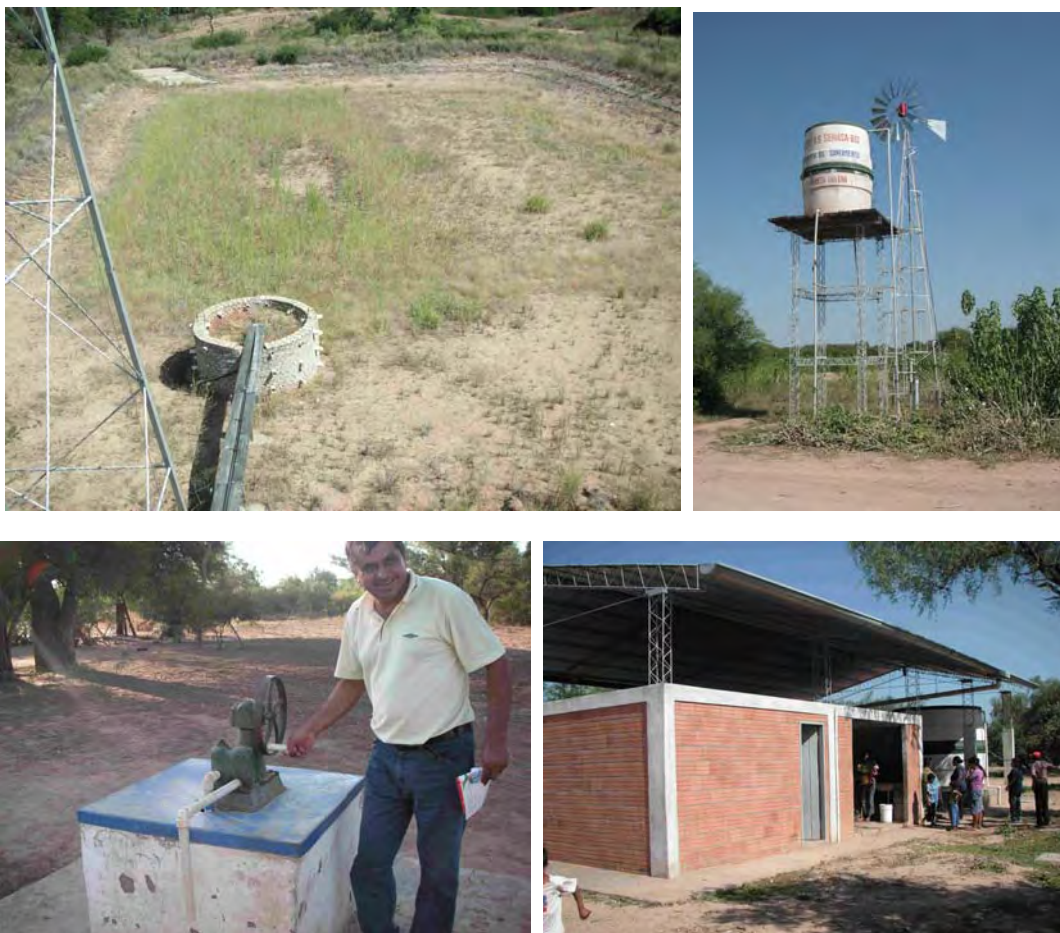
写真： タハマール(ため池)：左上、風車、高架水槽：右上、地下式貯水槽：左下、衛生施設(雨水集水)：右下
