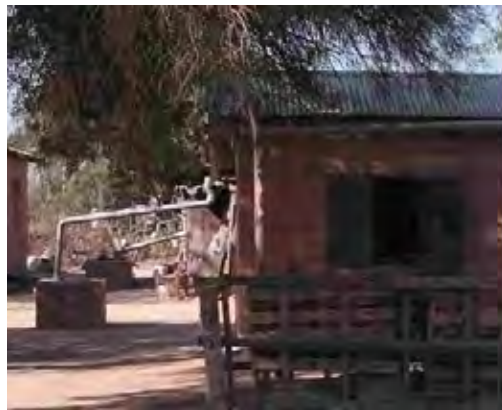
写真:雨水集水(民家屋根):左、地下式貯水槽:右
