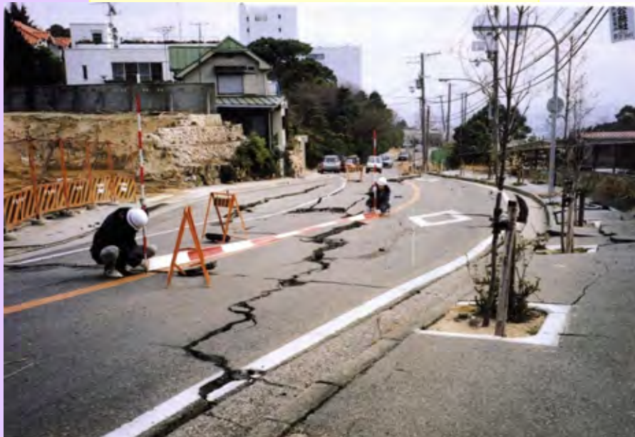
地下鉄駅の崩壊による道路陥没
