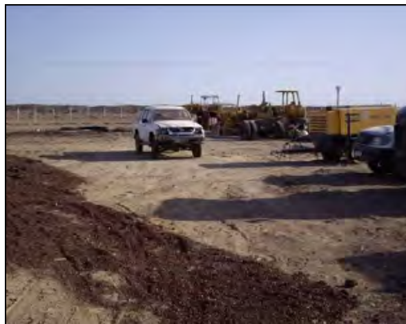
写真-2 アファール州供給施設建設公社(AWCE)内の建 設機械置き場 給水車などの調達機材の保管に十分な用地を所 有している。
