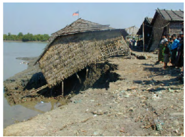
土壌浸食による家屋の倒壊
