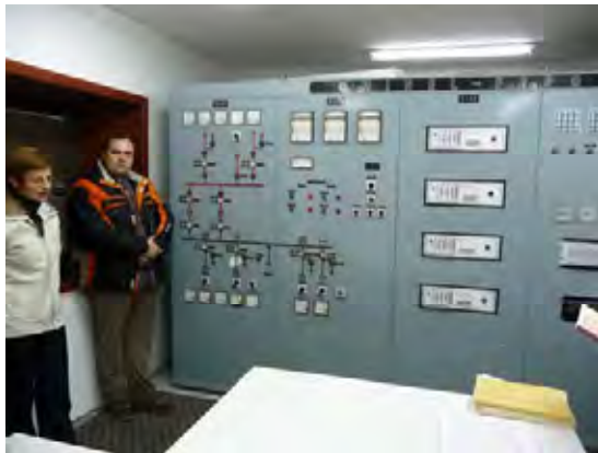
新ポンプ場のコントロールパネル。ポンプと併せて更新することが想定される。
