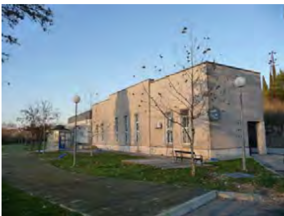
旧ポンプ場。建屋内に3台、建屋外に1台、合計4台のポンプがある。
