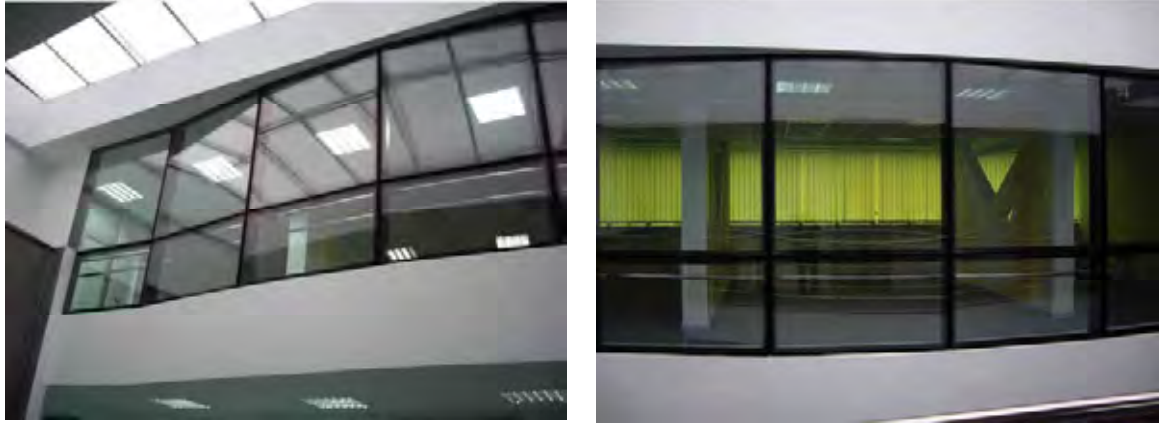
図 2-28 モニタリングシステム中央監視室
