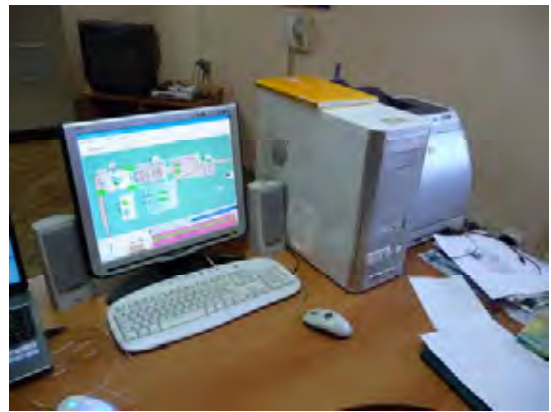
下水処理場に導入されているモニタリング装置。処理場内での監視にのみ使用されており、本部からの遠隔監視はしていない。
