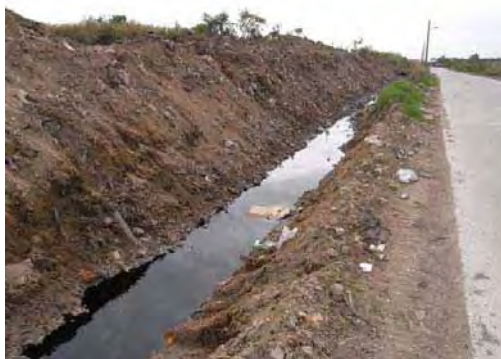
Calle100 処分場浸出水の排水溝
