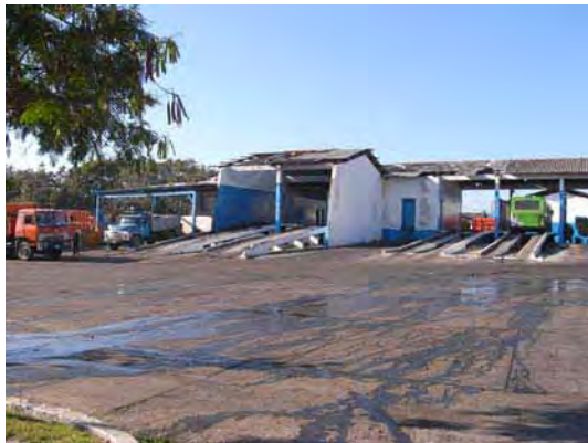
車輛整備場・修理工場全景
