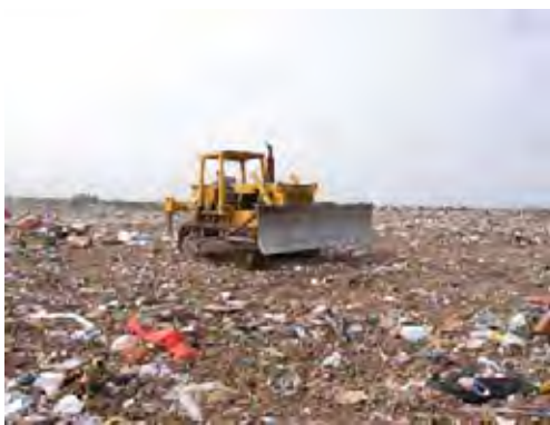
Calle100 処分場に配置されているブルドーザー
