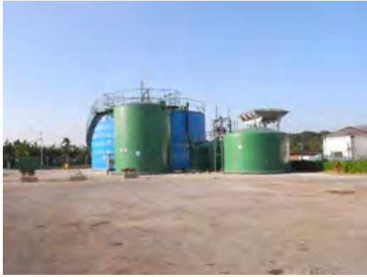
図 2-8 バイオガスプラント（左：発酵タワー、右：有機ごみ破碎・水混合ユニット）
