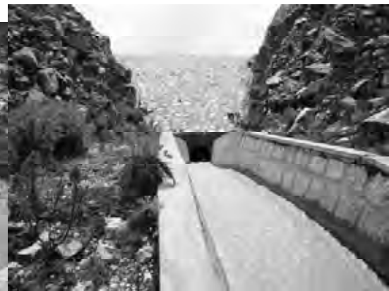
写真 8 上流側から見たダム堰堤の全景
