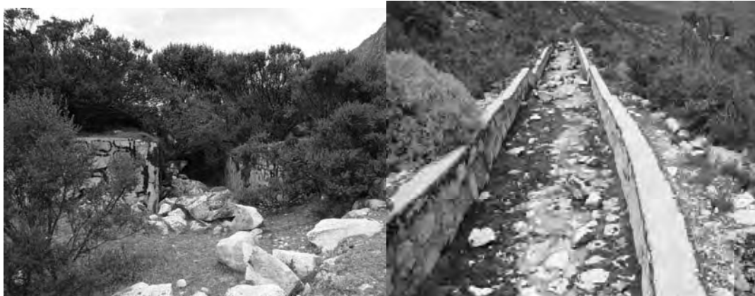
写真 7、8 湖の自然堤防上の余水吐
