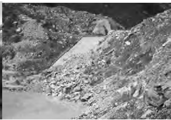
写真 6 右岸側モレーンからみたダム 堰堤
