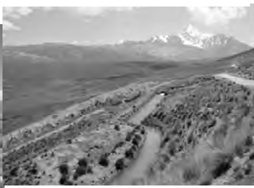
写真6 Milluni Chico 湖から Milluni 湖への水路、土でできた開水路なので、浸透や蒸発による損失は大きい。
