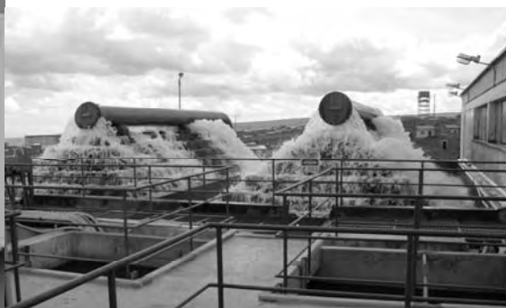
写真 6 エルアルト浄水場
