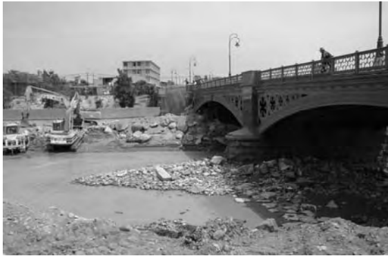
写真4 増水で壊れ修理中のリマ市内の Balta 橋。
