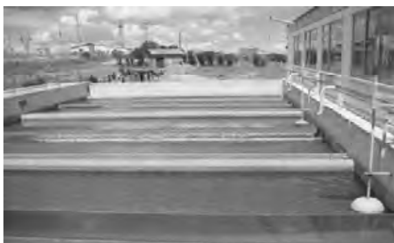
写真 7 エルアルト浄水場
