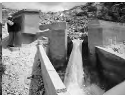
写真 8 Zongo 氷河からの流出量を 観測している量水所
