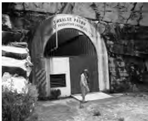
写真5 湖の右岸にあるトンネルへの入口
