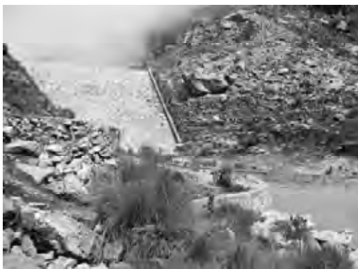
写真 7 左岸側から見たダム堰堤
