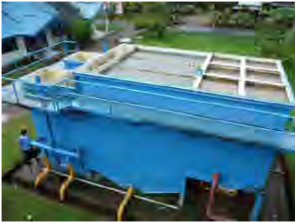
公共事業省が建設した 20 リットル/秒の急速 濾過式浄水施設。水質分析器がなく、水質が検 査されないまま配水されている。
