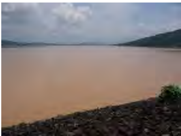
マカッサル市ソンバ・オブ浄水場の水源となっているビリビリダム。雨期であることもあり、貯水池の水は濁りが激しい。現在緊急砂防事業を円借款により実施中。
