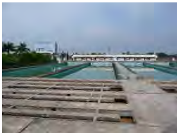
ソンバ・オブ浄水場のフロック形成池（手前）と沈澱池（奥）。
