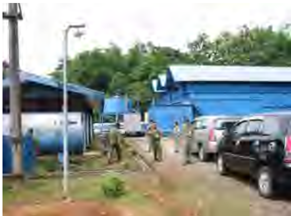
マロス県バンティンムルン浄水施設（水源：バンティンモロー川、浄水能力：80 リットル/秒、稼動開始年：1989年）。
