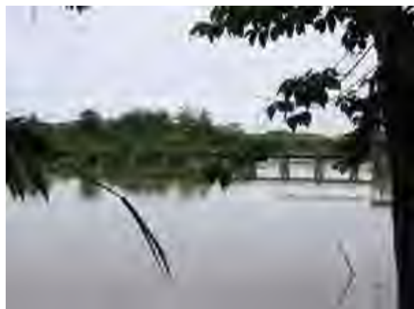
パットントンガ浄水施設とマカッサル市のパナイハン浄水場の水源となっているレコパンチン川の取水堰。乾季の水位低下が問題となっている。
