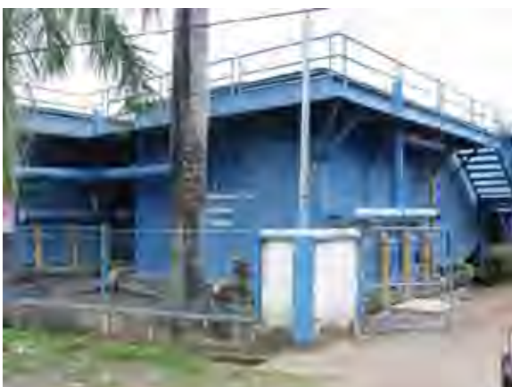
パندان・パندان浄水施設（水源：ジェネベラン川、浄水能力：200 リットル/秒、稼動開始年 1996 年）。同浄水施設のラボが現在中央ラボとなっている。
