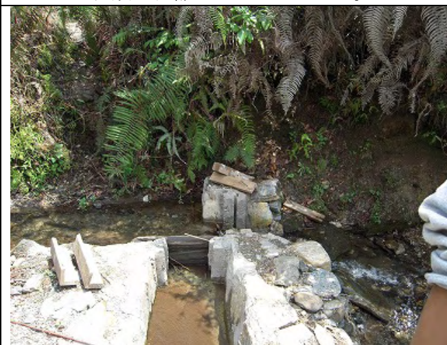
ドラカ郡チャリコット近郊え見かけた小河川からの灌漑用取水工。
