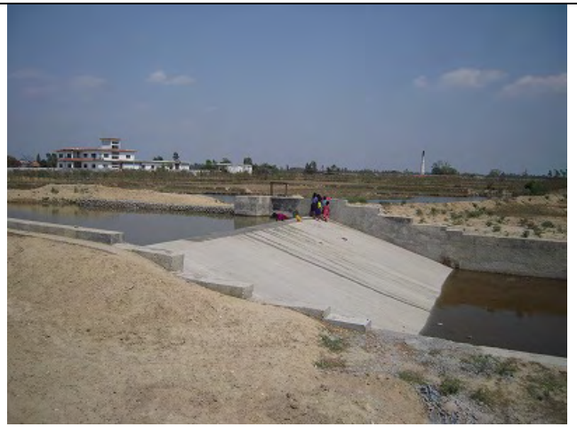
ジャナカプールに向かう道路脇に建設された頭首工。
