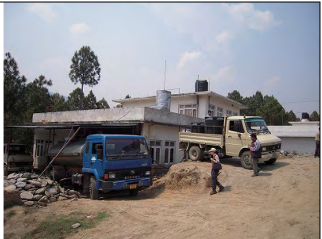
草の根無償で供与されたカブレ郡 Kurisak 牛乳協同組合のミルク冷蔵出荷施設
