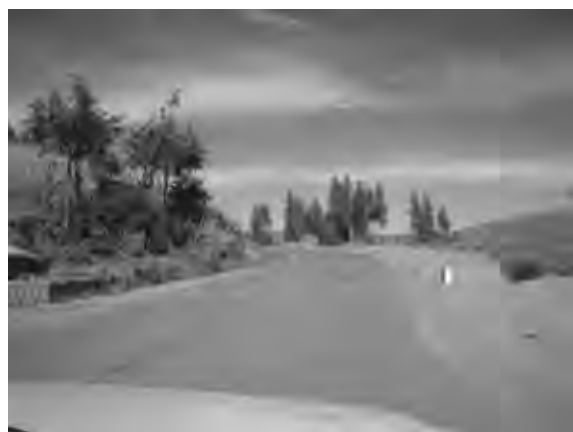
アスファルト舗装道路
