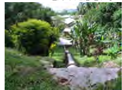
水槽から発電所
