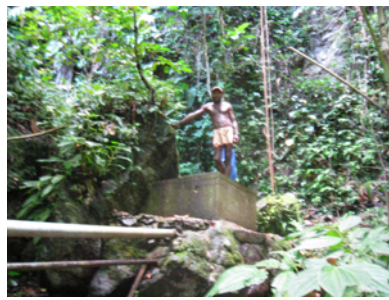
村への水供給用パイプ
