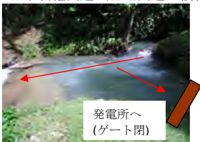
マルー発電所(SIEA) 取水堰 設計流量 0.2m 3 /s 取水口閉鎖により取水停止中
