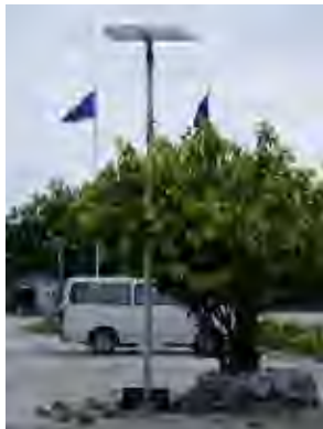
病院（既存の太陽光設備）
