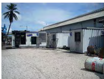
レンタルディーゼル発電機 (現在は稼働していない)
