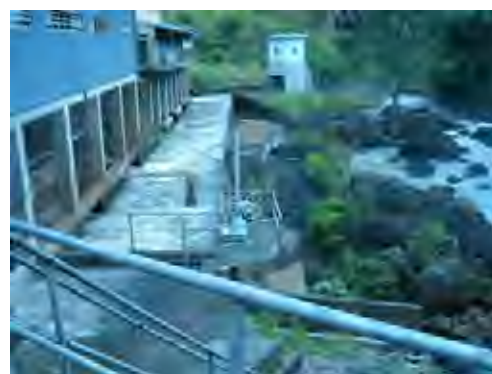
Rouna 1&3 の放水口 (Rouna 4 向けの水路)
