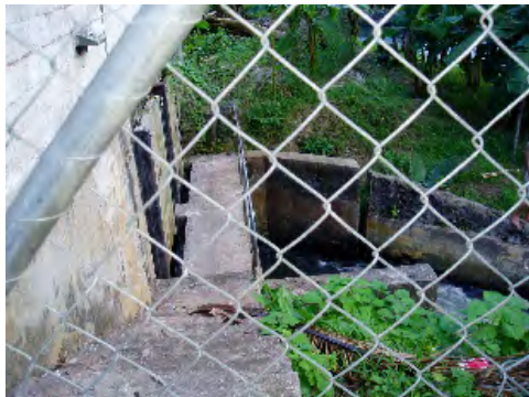
小水力放水口
