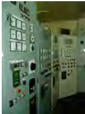
発電所 (コントロールパネル)
