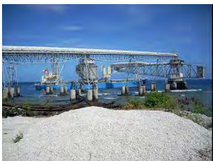
リン鉱石搬出用の港湾設備
