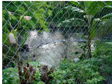
小水力 (放水後)
