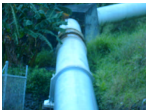
Rouna 3 ペンストックからの漏水
