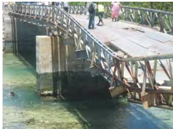
写真10 Tanaea地区とBuota地区を結ぶ橋梁の破
