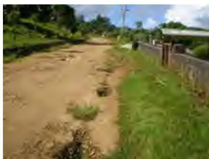
道路排水整備が悪く路面が損傷
