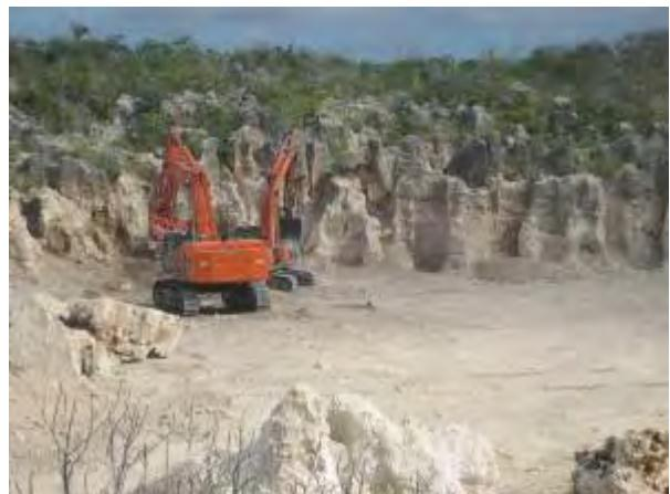
地表面の凹凸を平坦にして整地作業を行なっている。
