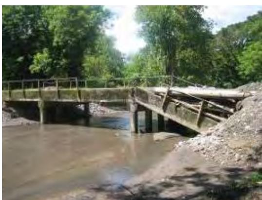
取り付け部が破損した橋梁。
