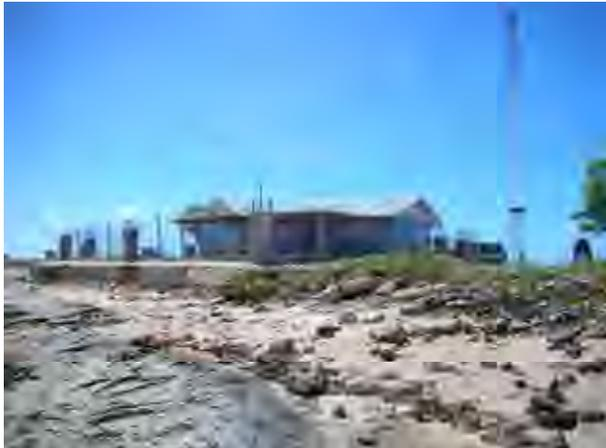
キリバスのラジオ送信所の海岸浸食状況。ラジアルアースの一部が波で流失している。
