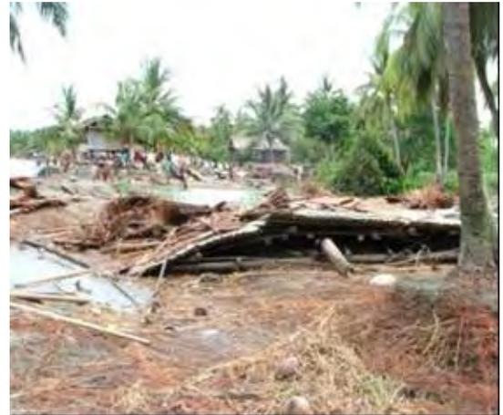
写真 2-2.9 サイクロンによる家屋損壊 (NDC 提供)
