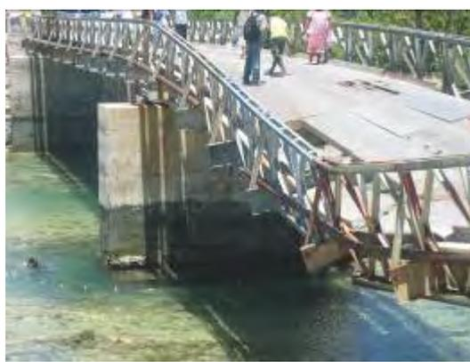
写真 2-2.4 橋げた側面の水道管の破損状況
