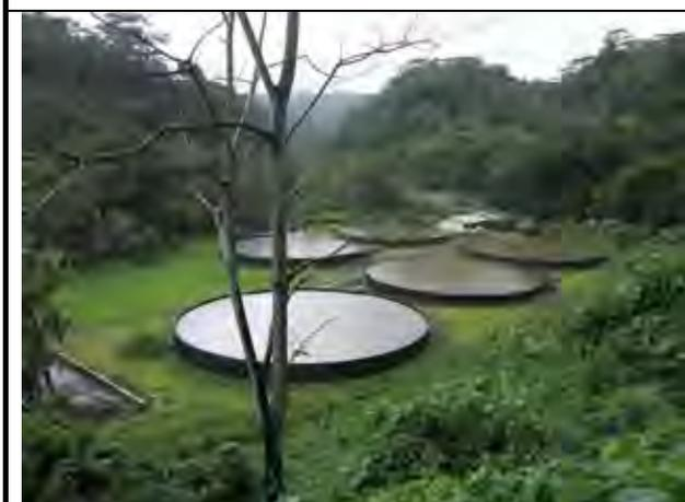
首都アピアの主要浄水施設(ALAOA 緩速ろ過施設-サモア)。豪雨が発生すると原水濁度が高くなり、ろ過池の閉塞が発生する。
