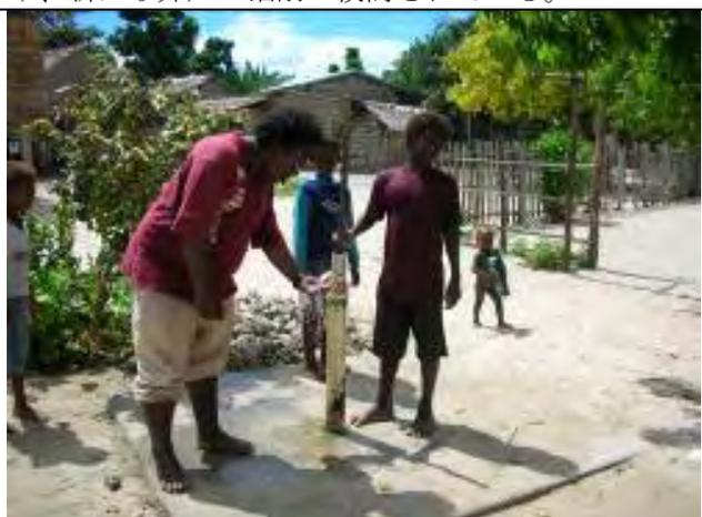
ソロモン諸島アウキ州クワイ島（アウキ島の離島）の井戸。海水浸入により塩水化している。
