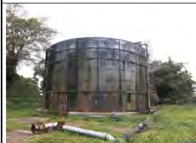
スチール製配水池(ルーガンビル-バナアツ)。緊急時にも給水を可能にする配水池は老朽化が著しい。
