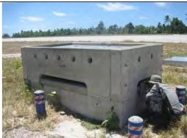
キリバスのタラワ公共給水の水源井戸。塩水化が進み、新たな井戸の掘削が検討されている。
