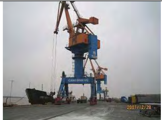
写真一2 ハイフォン Dinh Vu 港 近い将来、ハイフォン港に匹敵するコンテナ 取扱が見込まれ、本計画での調達機材活用が期 待される。
