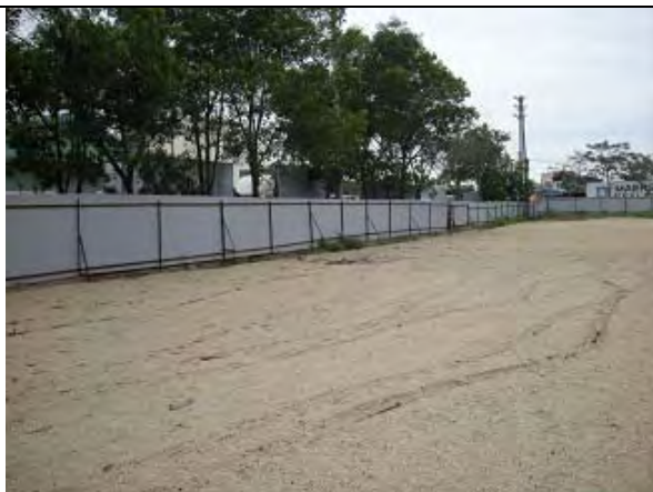
写真—9 ハイフォン港 X 線検査場 地盤改良工事後 (北西方向)
