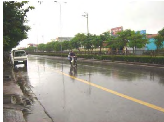
写真一3 ハイフォン港 X 線検査場予定地の 前面道路。両側 4 車線で国道 5 号線と ハイフォン港に近い。市内環状線高速道路に 連結される予定。
