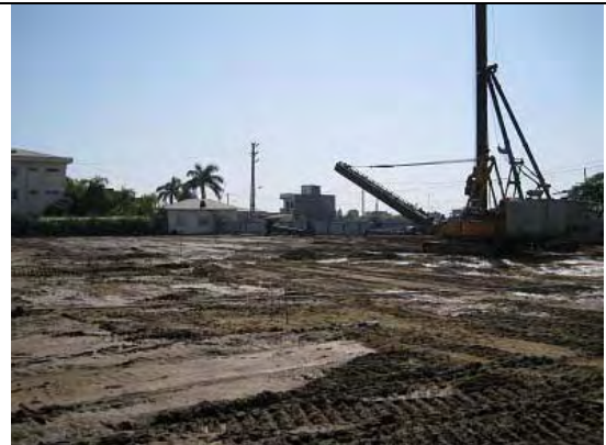
写真一4 ハイフォン港 X 線検査場 地盤改良工事中当時
