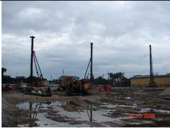
写真—5 ハイフォン港 X 線検査場 地盤改良工事中当時
