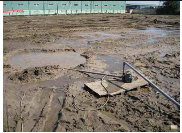
写真—6 ハイフォン港 X 線検査場 地盤改良工事中当時
