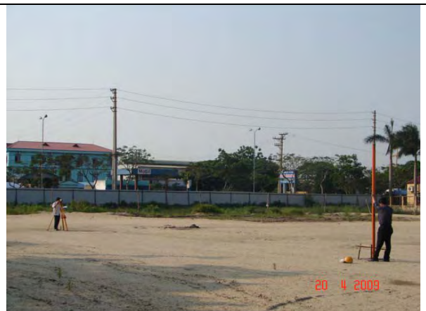
写真—10 ハイフォン港 X 線検査場 地盤改良工事後沈下量計測
