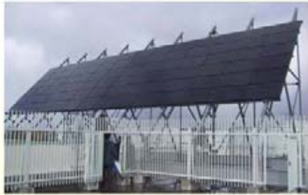
PV Array 10kW
