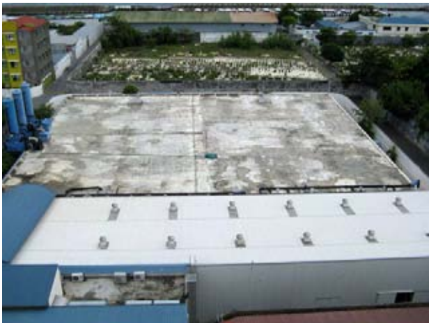
MEEW 南側の浄水施設
