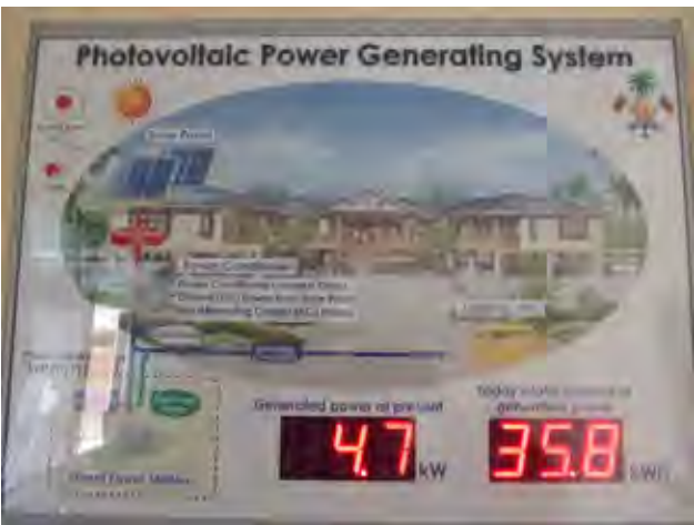
ラーム環礁 PV 設置場所視察
