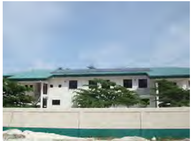
ラーム環礁太陽光発電（PV）設置場所視察
