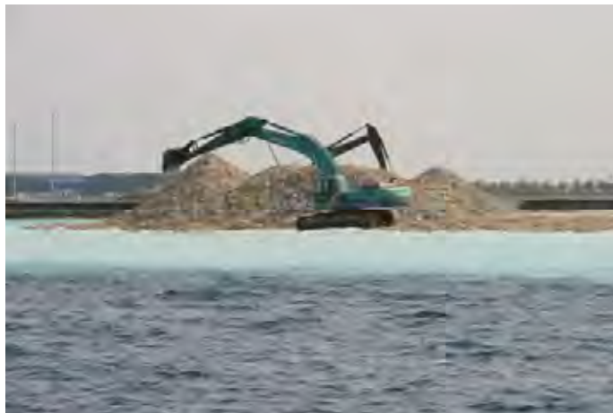
図 8 - 3 フルマレ島の埋め立て工事
