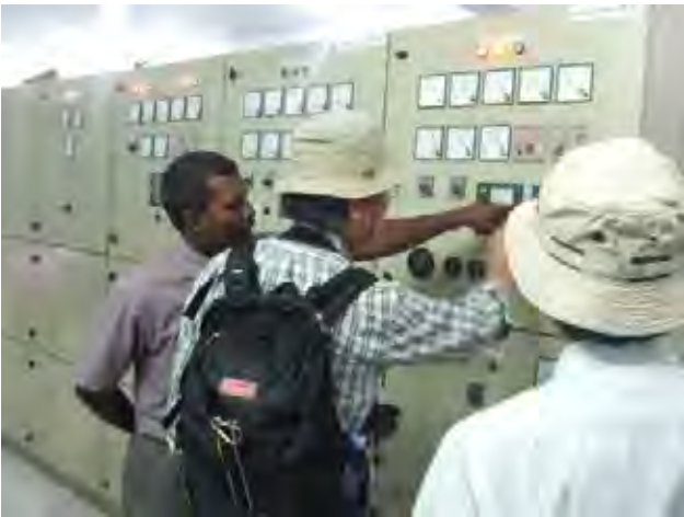
フルマレ島 STELCO 発電所視察
