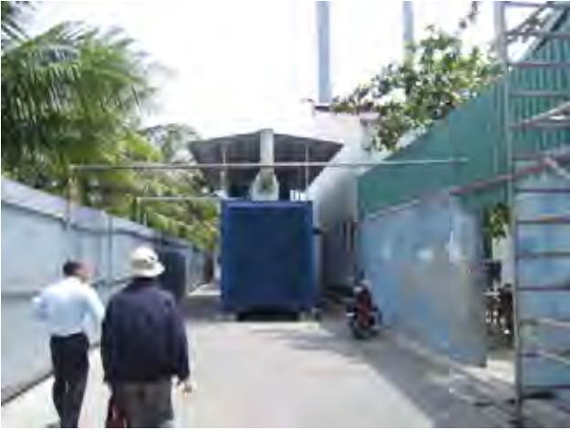
公道を封鎖して設置されている発電機（マレ島）
