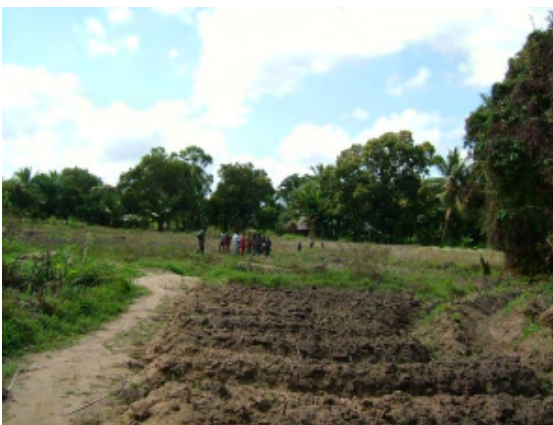
敷地内建設予定地、後方の樹木付近には仮設住居がある。工事には搬入路の設置が必要となる。
