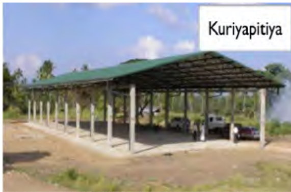
クリヤピティアUCのコンポストプラント建設現場
