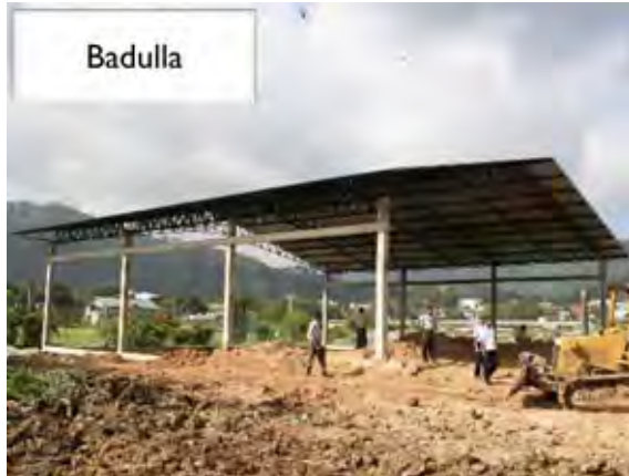
バドゥッラMCのコンポストプラント建設現場
