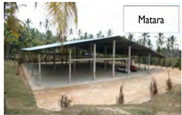
マータラMCのコンポストプラント建設現場
