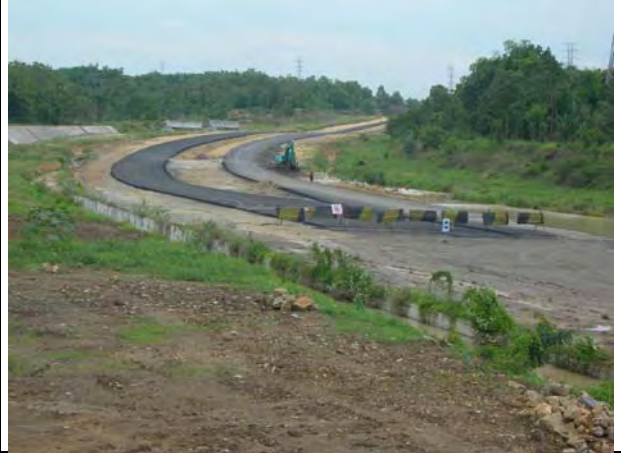
マドゥラ島内のスラマドゥ橋のアプローチ道路。スラマドゥ橋及びアプローチ道路が完成すれば、交通流動は激変するものと思われる。
