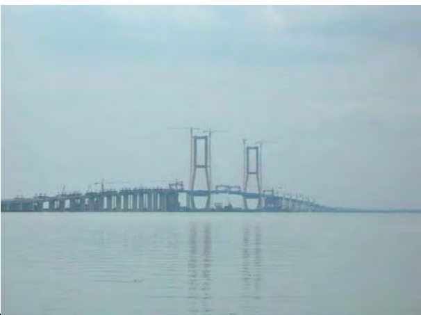
中国の援助による建設中のスラマドゥ橋。橋長5.4 km、中央径間818mの斜長橋。供用開始は2009年内と考えられている。
