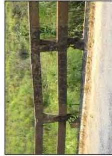
⑥車両の衝突により損壊した高欄
