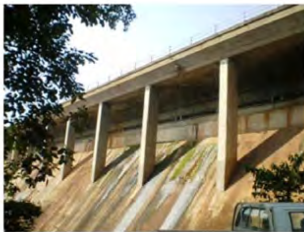
橋脚、橋版の状況
