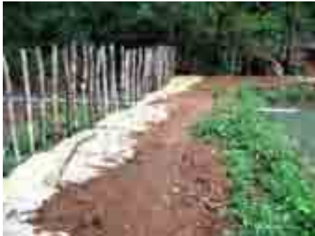
Ống dẫn nước
