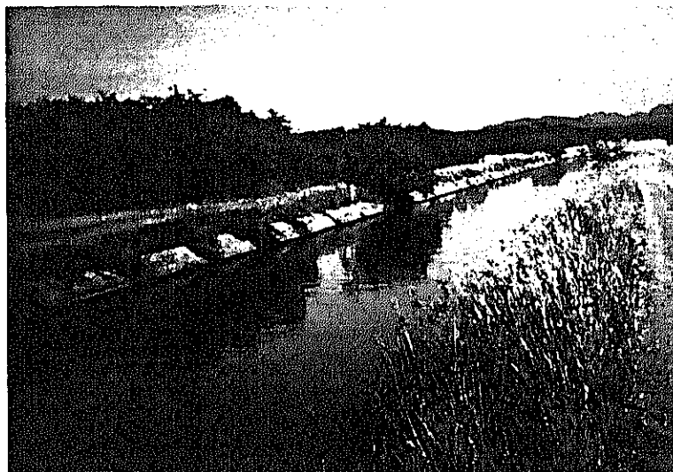
写真-1. リオ・トマトラン灌漑プロジェクト幹線水路
