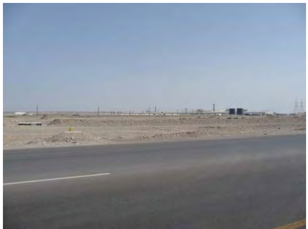
ソハールSEZ ( 建設中のアルミ精錬所 )
