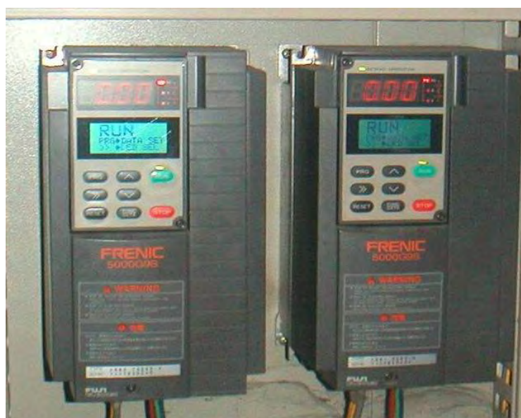
図 3.3.2-13 テンター、乾燥機ファン用インバータ
