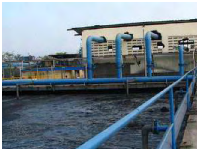
図 3.3.2-24 バンドン近郊の染色企業の曝気槽へ送気管
