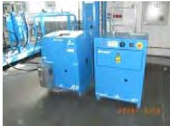
インバータなしの新コンプレッサの増設
