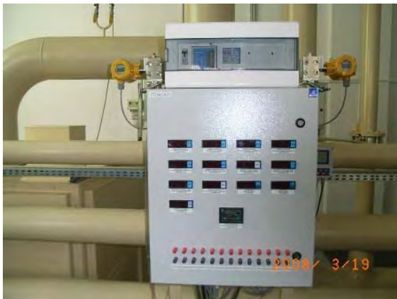
データ・インターフェースの追加：PCへの接続可能につき測定データが即時グラフ化可能となった（2008年3月撮影）
