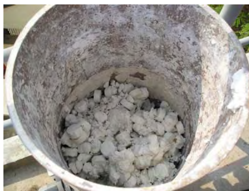
Рис. 3.1.13 Оборудование дезинфекции твердым хлором
