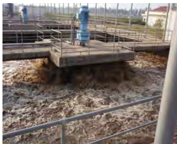
Рис. 3.1.4 На КОС Сев. Thang Long применена методика поверхностной аэрации
