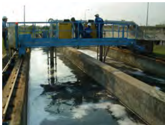
Рис. 3.1.25 Песколовка: проводятся работы по техосмотру
