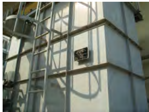
Рис. 3.1.11 Оборудование дезодорации, в котором применяется активированный уголь
