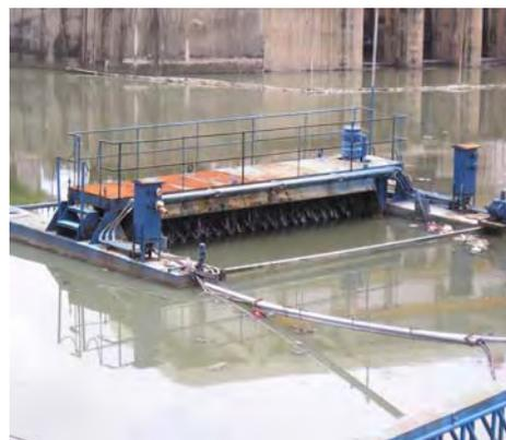
Рис. 2.1.7 Установленный аэратор
