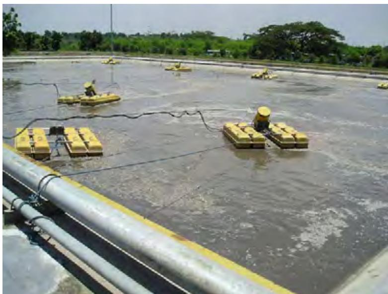
Рис. 2.1.38 Аэротенк (метод длительной аэрации)
