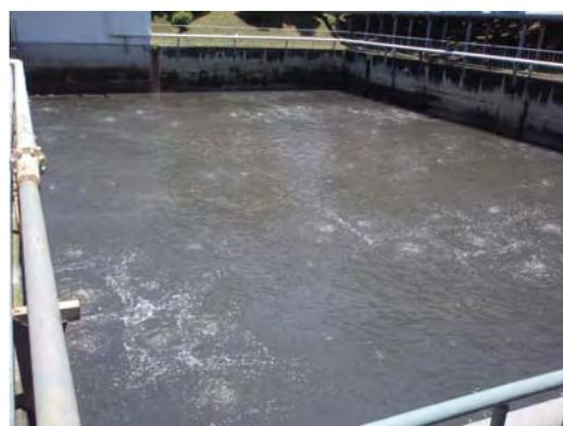
Рис. 2.1.41 Регулирующий резервуар неочищенных стоков
