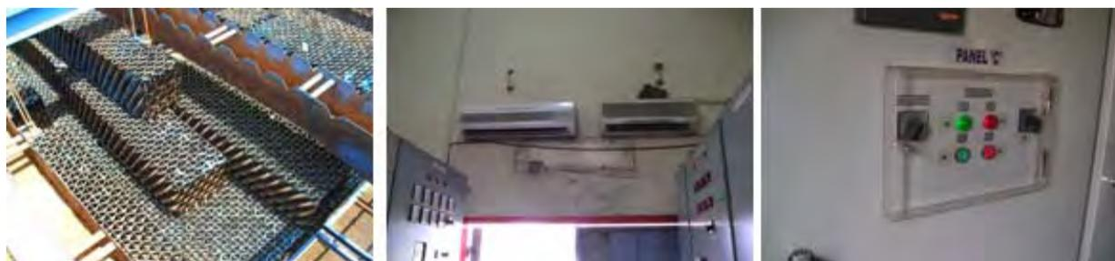
Наклонная плита отстойника
