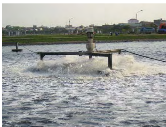
図 3.1.24 曝気池の表面曝気機
