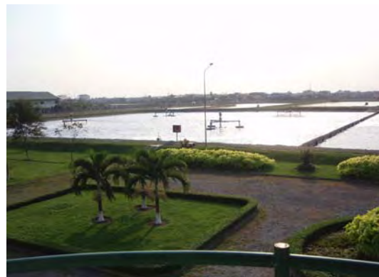
図 3.1.17 ビンフンホア処理場全景
