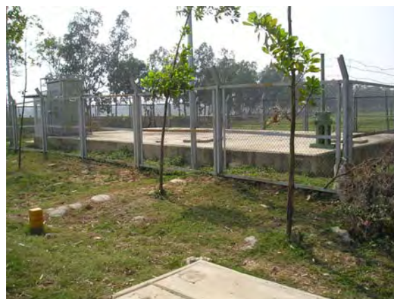
図 3.1.5 処理場近隣のポンプ場
