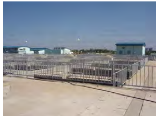
図 3.1.15 ビンフン処理場全景
