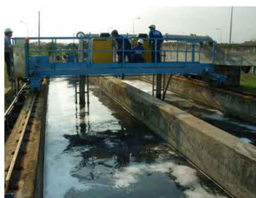
図 3.1.25 沈砂池及び点検作業
