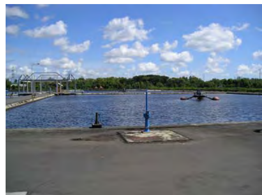
図 2.1.9 スウォン下水処理場
