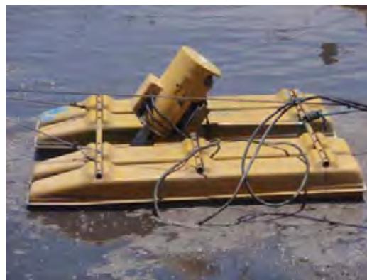
図 2.1.42 斜軸スクロー型曝気機
