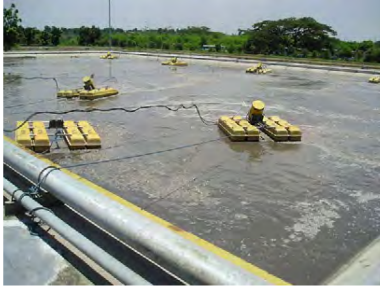
図 2.1.38 反応タンク（長時間エアレーション法）
