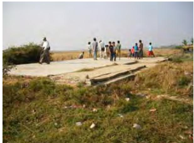
写真-4: 完全に崩壊してしまった既存校舎跡。(Bogale No.18-Sat Kyun)
