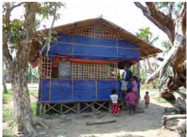
写真-6: 仮設校舎の多くは木造、ビニルシートで覆っただけの簡易な作りであり、恒久的な構造物にはなっていない。(Labutta No.2-Shwe Gone)
