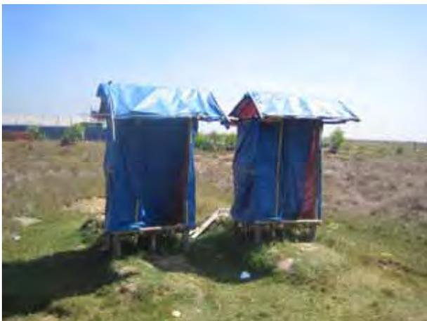
写真-9: 仮設トイレ。地面に掘った穴に直接つながっているため、衛生状態は悪い。(Labutta No.14-Thin Gan Lay)
