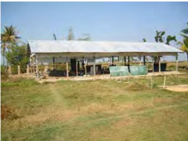
写真-3: ナルギスにより柱と屋根のみが残された既存校舎。被災から一年以上経った今も再建されていない。(Labutta No.4-Zin Pyune Gone)
