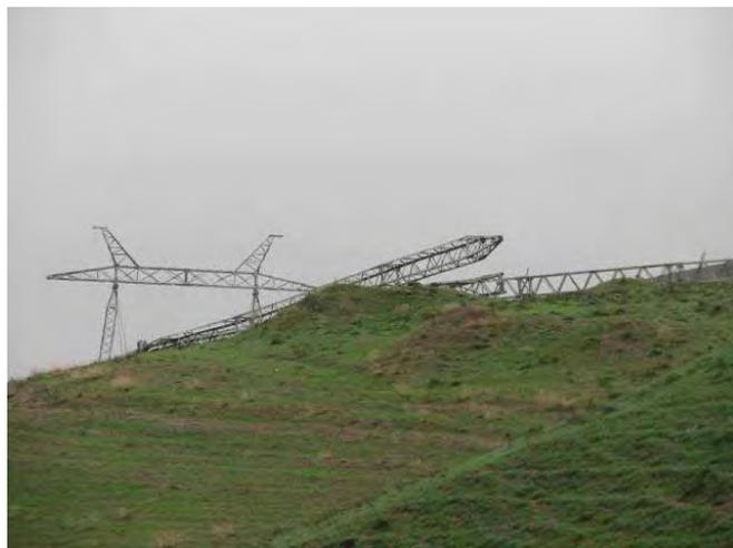
写真 2-12 倒壊した鉄塔
