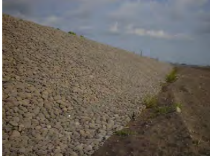
写真 2-11 自国政府資金により設置された河川堤防および護岸工（アチグアテ川）
