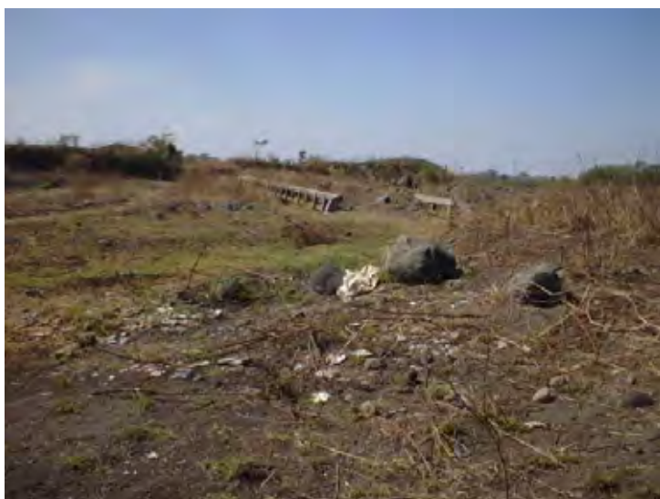
写真 2-2 洪水で運搬された土砂で埋没した橋梁 (太平洋沿岸サマラ川下流)
