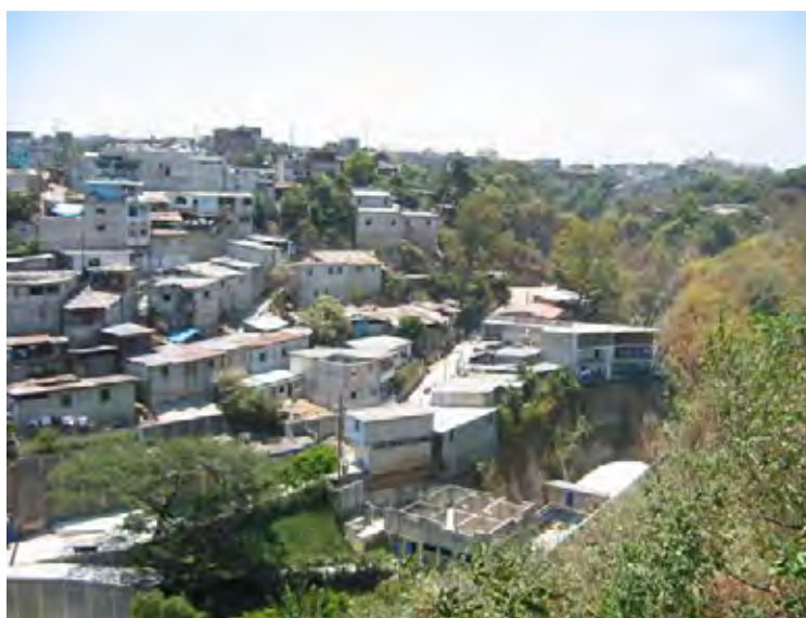
写真 3-3 グアテマラ市の急傾斜地を不法占拠した居住地
