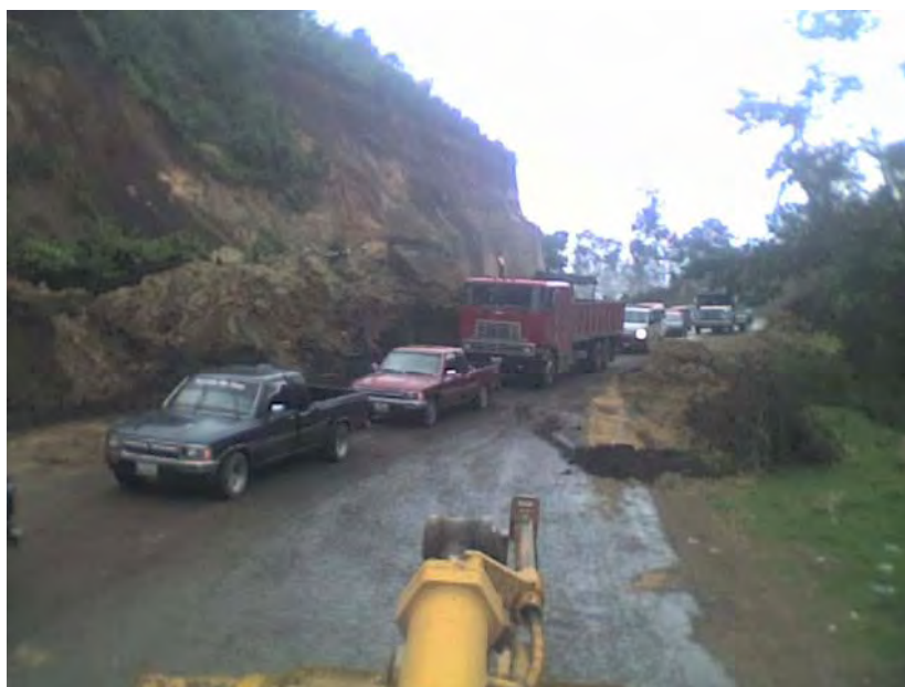
写真 3-1 のり面崩壊状況
