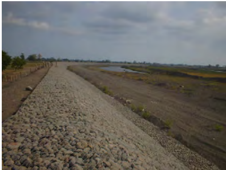
写真 2-8 アチグアテ川下流の堤防整備
