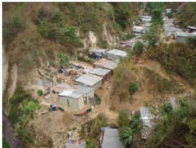
写真 2-5 グアテマラ市内の不安定な急傾斜地
