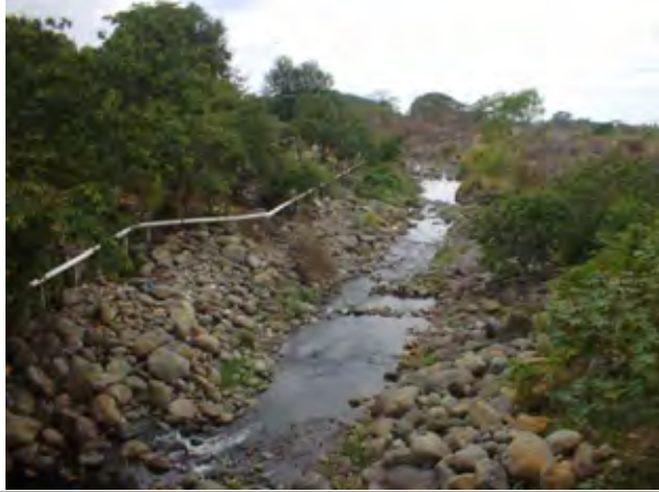
3. サマラ川左支川エル・ニーニョ川 CCA橋 (CA2)下流で合流する当河川の洪水は、 本川背水の影響によりCA2を冠水させる。
