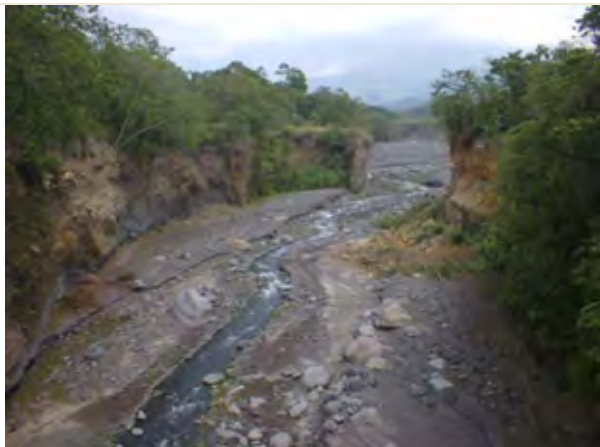
5. サマラ川上流の支川ニマ1川 急流により河岸が激しく侵食されている。
