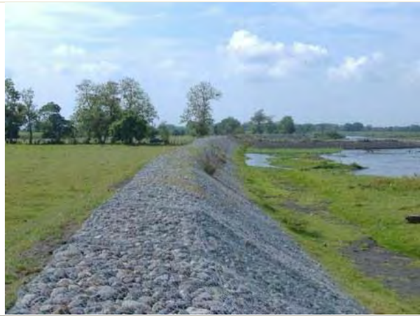
13. アチグアテ川の護岸工 自国資金により工事を実施している。 (出典：MICIVI DGC UNIRIOS)
