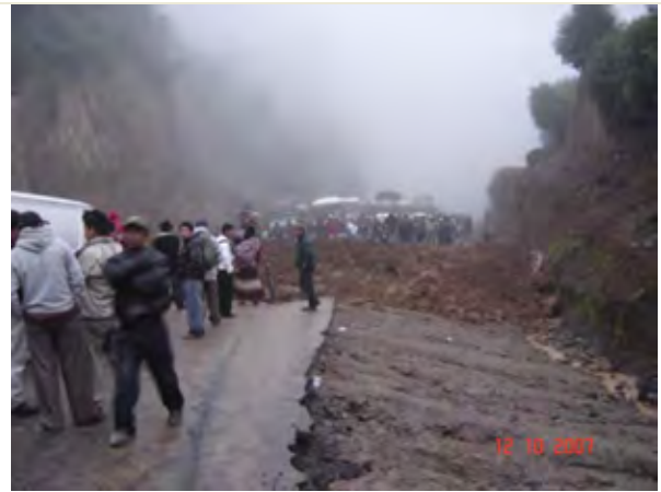
10. CA1の土砂崩れ 2007年10月に発生したのり面崩壊 (出典：MICIVI DGC UNIRIOS)
