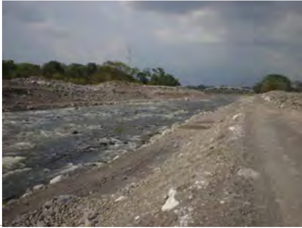
1. サマラ川 カルロス・カルティージョ・アルマス(CCA)橋 (CA2)下流でのCIVにより掘削・整正された河 道。
