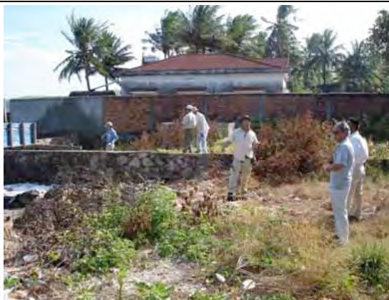
⑤海水取水管埋設予定地を見る、取水施設陸側の用地は確保されている
