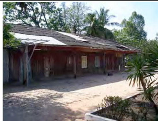
④サイト内既存事務所棟（「カ」国側により撤去）を見る、老朽化が進んだ本事務所はサイト近隣に新築される
