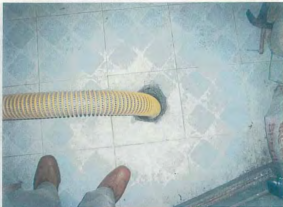
2月22日(金)午前 Septic Tank引抜作業視察
