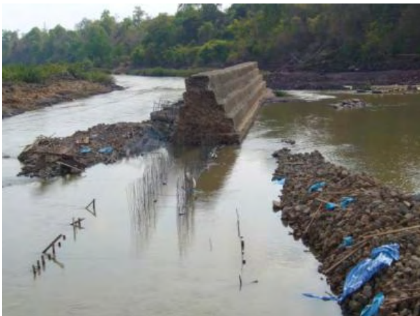
放水路導流堤補修状況。2008年4月EDL撮影。
