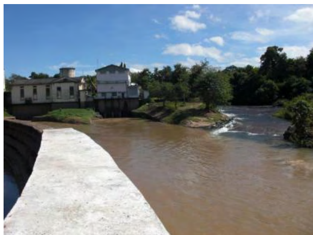
合流部。余水路との合流部。
