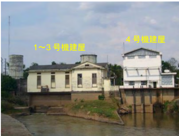
発電所建屋。放水路側より望む。右が4号機建屋、左が1～3号機建屋。更に左が5号機建屋予定地。
