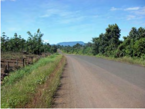
国道 16 号。パクセより東に延びる国道 16 号。
