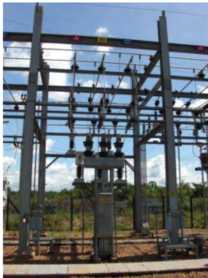
Bang Yo -Selabam 22 kV フィーダ。セラバム発電所の拡張に合わせて LS, CT 等は更新する必要があるが、Bang Yo 変電所設備の更新は EDL の負担により実施する計画。
