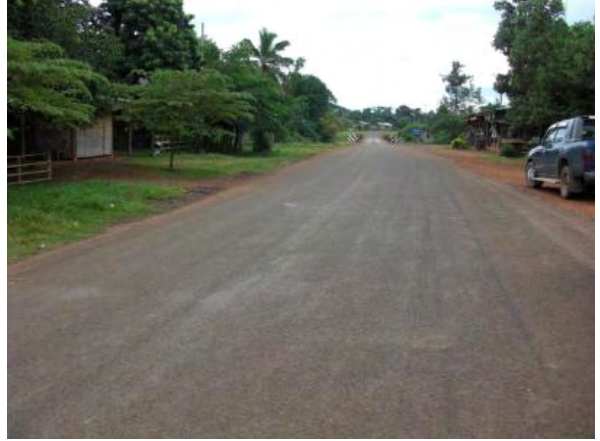
国道 17 号。国道 16 号より北方へ分岐する国道 17 号。数か所耐荷重 T-20 相当のベイリー橋が架かる。
