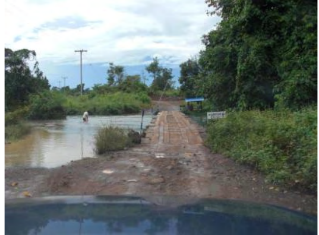
地域管理橋。ゲートが設けられ、通行料が必要。重量物は通行できないため、4号機建設の際には、乾季に橋の画面左側（人がいる辺り）を通行したとのことである。
