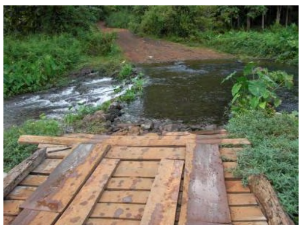
河川横断部。比較的浅いため、トラック等クリアランスの大きい車両は通行可能である。
