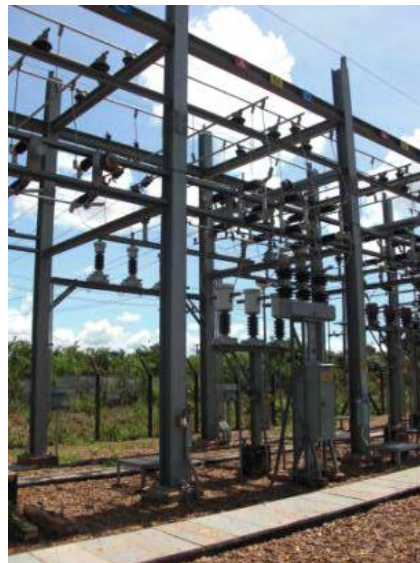
Bang Yo -Selabam 22 kV フィーダ。セラバム発電所の拡張に合わせて LS, CT 等は更新する必要があるが、Bang Yo 変電所設備の更新は EDL の負担により実施する計画。
