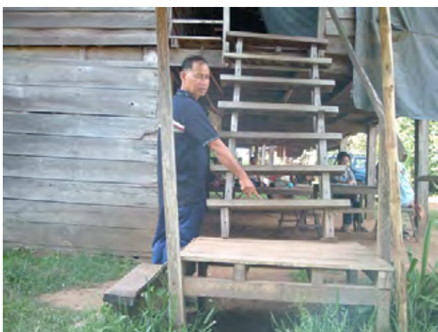
発電所上流部。2007年の洪水時は、男性の指先の位置まで浸水した。
