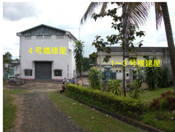
発電所建屋。左が4号機建屋、右が今回撤去要請のあった1~3号機建屋。1~3号機建屋の手前が所内開閉所。
