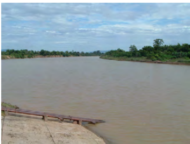
発電所上流部。乾季はセドン川の水を灌漑用水として利用。
