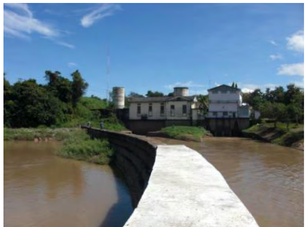
放水路導流堤修繕箇所。2008年4月に放水路導流堤崩落の補修を実施。既設は石積にモルタルを拭き付けた構造。改修箇所は鉄筋コンクリートにより築造。雨季にセドン川流量の増加により、放水口水位が上昇するのを低減する役割を有する。
