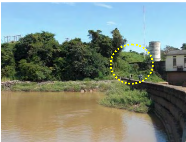
5号機建屋建設予定地。1~3号機建屋を撤去せず、西隣のスペースに建設予定。
